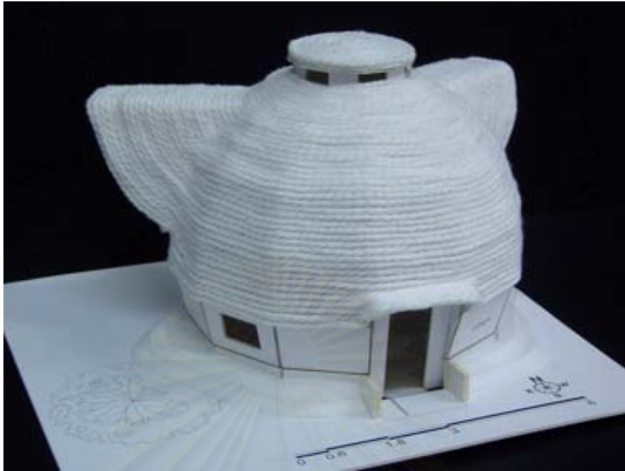
รูปที่ 4-15 แสดงหุ่นจำลองลักษณะของบ้านพักอาศัยสำหรับครอบครัวขนาดเล็กที่ออกแบบ ด้วยการลดพื้นที่เปลือกอาคารลดค่าใช้จ่ายโดยรวม เมื่อใช้วิธีการก่อสร้างด้วยผนังฉนวนกันความร้อน ภายนอกสำเร็จรูปในส่วนของผนังที่มีช่องเปิด ร่วมกับผนังโครงเหล็ก ใช้ฉนวนพันรอบ พ่นหรือเคลือบผิวคอนกรีตภายนอกในส่วนของผนังที่ต่อเนื่องกัน
