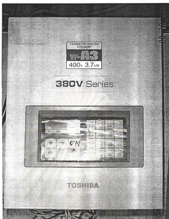
รูปที่ 4.10 แสดงอุปกรณ์ปรับความเร็วรอบของมอเตอร์
