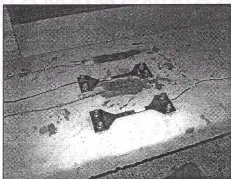
รูปที่ 3.8 แสดงการติดตั้งอุปกรณ์วัดความเครียดในสะพานที่เรียบร้อยแล้ว
