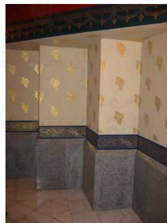
รูปที่ 4.2.8-80 ผนังตอนบนเป็นลายฉลุปิดทองคั่นด้วยลาย หน้ากระดานฉลุปิดทองบนพื้นสีน้ำเงิน ผนัง ตอนล่างเป็นหินแกรนิตสีเทา
