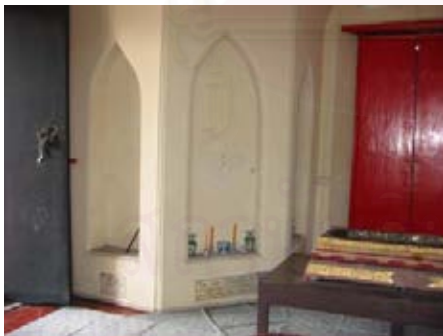
รูปที่ 4.1.2-4 ผนังภายในทำเป็นคูหา ทั้งนี้อาจทำเพื่อช่วยลดน้ำหนักโครงสร้างและช่วยรับแรงกดจากน้ำหนักด้านบน นอกจากนี้ถ้าไม่คำนึงถึงการรับน้ำหนักแล้ว ช่องคูหา ยังเป็นการประดับตกแต่งผนังด้วย
