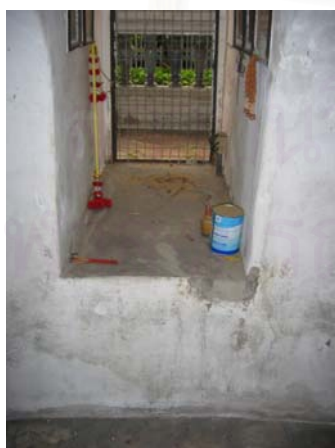
รูปที่ 4.1.6-6 จากภาพเห็นได้ว่าพื้นภายในมีระดับต่ำกว่าพื้น ลานประทักษิณ อาจจะเป็นผลจากที่ต้องการให้ ความสูงเพียงพอต่อการใช้งานภายใน
