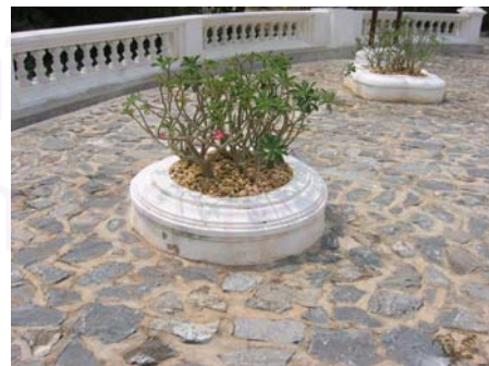
รูปที่ 4.1.9-18 กระบะปลูกต้นไม้
