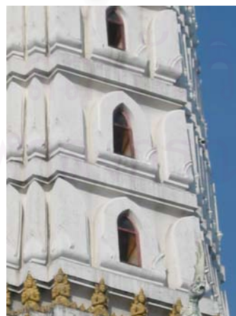
รูปที่ 4.1.5-42 ชูมวิมานของยอดปราสาทเจาะเป็นช่องระบายอากาศ
