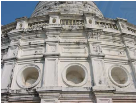
รูปที่ 4.1.3-32 การประดับตกแต่งผนังของส่วนฐานพระเจดีย์ ลักษณะเป็นเสาตั้งซ้อนกัน 2 ชั้น แล้วเพิ่มองค์ประกอบ ที่เป็นช่องวงกลม และเส้นบัว แทนช่องคูหา เมื่อ เปรียบเทียบกับการตกแต่งในส่วนระเบียงคด
