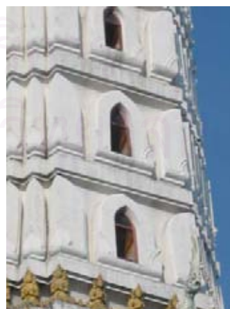
รูปที่ 4.1.5-49 ช่องระบายอากาศที่ซุ้มวิมานของยอดปรางค์ประธาน
