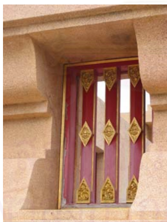
รูปที่ 4.2.5-12 ช่องระหว่างฐานชั้นที่ 2 ประดับด้วยซี่ลูกกรงไม้ทาสีแดง ตัวลายเป็นสีทอง
