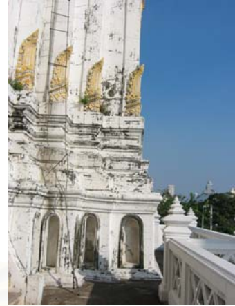
รูปที่ 4.1.5-23 ฐานของพระเจดีย์บิวารนั้นเป็นฐานสิงห์บัว ลูกแก้วอกไก่ซ้อนอยู่บนฐานปัทม์อีกชั้นหนึ่ง ซึ่งในส่วนท้องไม้เจาะเป็นช่องโค้งกลม
