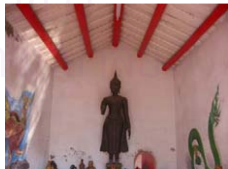
รูปที่ 4.1.2-31 ภายในแก่งจันแสดงโครงสร้างหลังคา แปกกลมทาด้วยสีแดง กลอนทาศูด้วยสีขาว ส่วนผนังเขียนจิตรกรรมขึ้นภายหลัง
