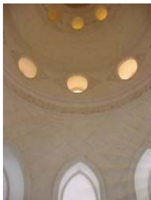
รูปที่ 5.8.4 โครงสร้างรับองค์ระฆังของพระเจดีย์วัดอัมพวันคีรีนคร จะต้องมีเสาและ Arch มารับน้ำหนักโดยรอบ
