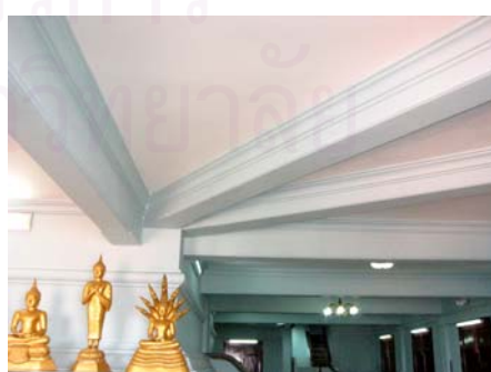
รูปที่ 4.1.7-28 โครงสร้างแบบเสา – คาน คอนกรีตเสริมเหล็ก
