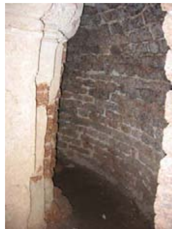
รูปที่ 3.6.6 ภายใต้งานพระเจดีย์ส่วนที่เป็นองค์ระฆัง ด้านซ้ายเป็นแกนรับน้ำหนักกลางเจดีย์ ด้านขวาเป็นผนังก่อศิลาแลง จะเห็นได้ว่ามีพื้นที่ที่เป็นที่ว่างภายในน้อยมาก
