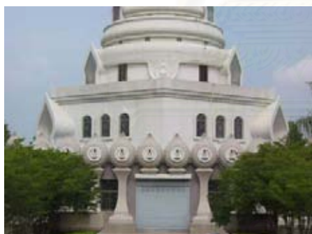
รูปที่ 4.2.3-10 ฐานชั้น 2 ทำซุ้มประตูยื่นออกมาจากผนังชัดเจน ส่วนหน้าต่างนั้นทำเป็นกรอบเซ็ดหน้ายื่นจากผนังเล็กน้อยเท่านั้น
