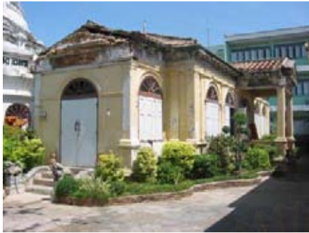
รูปที่ 4.1.3-2 อาคารคลุมทางเข้า เป็นสถาปัตยกรรมแบบตะวันตก มีทางเข้า 3 ด้าน
