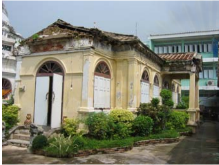
รูปที่ 4.1.3-18 ผนังอาคารทำด้วยสีเหลือง ประดับด้วยลายปูนปั้น หลังคาเป็นกระเบื้องดินเผา
