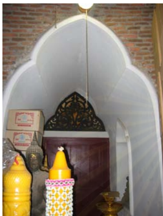
รูปที่ 4.1.8-30 ผนังเจดีย์เป็นช่องคูหาเพื่อลดน้ำหนักโครงสร้าง
