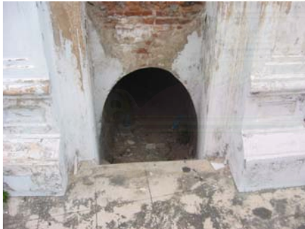
รูปที่ 4.1.3-14 ทางเข้าภายในองค์พระเจดีย์มีความกว้างประมาณ 65 ซม.
