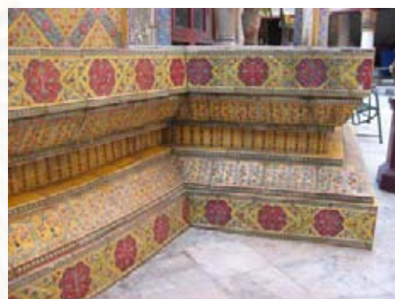
รูปที่ 4.1.8-15 ฐานปัทม์ ประดับด้วยกระเบื้องใช้สีเหลืองและม่วงเป็นสีหลัก
