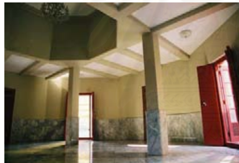
รูปที่ 4.2.7-6 พื้นที่ภายในส่วนฐานชั้นที่ 2
