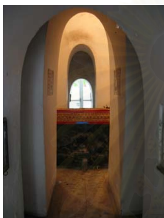
รูปที่ 4.1.6-32 แสงสว่างในพื้นที่ชั้นล่างได้มาจากช่องเปิด 4 ช่อง เช่นเดียวกับการระบายอากาศ
