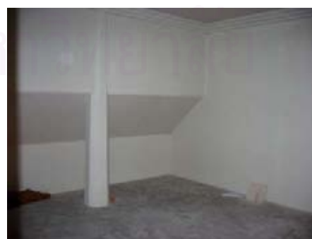
รูปที่ 4.2.8-31 พื้นที่ห้องใต้หลังคา
