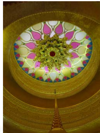
รูปที่ 4.2.3-19 แสงที่ได้จากการเจาะช่องที่บริเวณองค์ระฆัง ลงมาผ่านฝ้าเพดานพลาสติกสี เป็นการให้แสงสว่างและประดับตกแต่งไปพร้อมกัน
