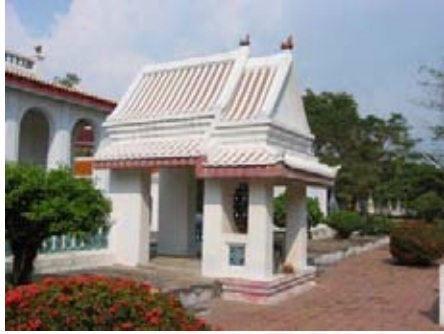
รูปที่ 4.1.2-32 ศาลฤกษ์ มุงกระเบื้องไม่เคลือบสี มีการประดับตกแต่งแบบอิทธิพลจีน เช่นเดียวกับอาคารอื่นๆ
