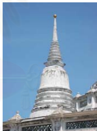
รูปที่ 4.1.3-27 พระเจดีย์บริวารทางด้านซ้าย หยอดน้ำค้างบนสุด ปิดด้วยทองคำเปลว
