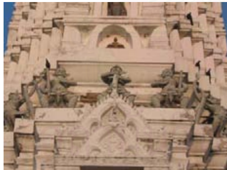
รูปที่ 4.1.1-13 ชั้นอัสตง ส่วนที่เหนือจากซุ้มจะนำขึ้นไปเป็นยักษ์ถือกระบองยืนเรียงกัน 3 ตน
