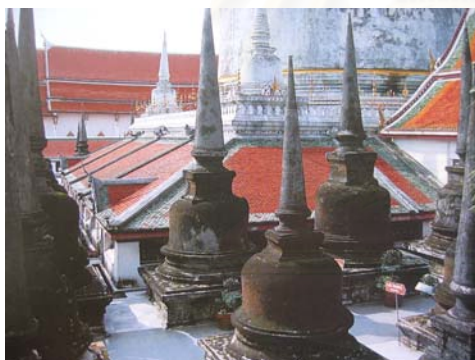
รูปที่ 3.2.6 ทับเกษตรที่เป็นหลังคายื่นโดยรอบฐานพระเจดีย์ และ วิหารม้า (ด้านขวาของรูปภาพ)
