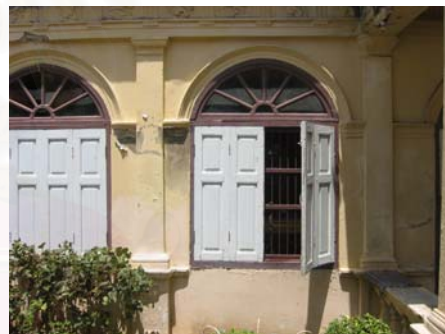
รูปที่ 4.1.3-21 หน้าตงบานไม้ด้านบนทำเป็นช่องแสงโค้ง ลูกฟักกระจก
