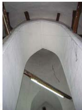
รูปที่ 4.1.6-35 การใช้ไม้มาช่วยในการรับแรงของส่วนผนังโค้ง
