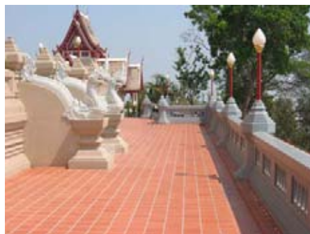
รูปที่ 4.2.4-5 ลานประทักษิณชั้นล่าง มีบันไดขนาดเชื่อมมาจากลานประทักษิณชั้น 2
