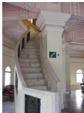
รูปที่ 4.2.3-21 โครงสร้างบันไดที่โค้งตามแนวเสา
