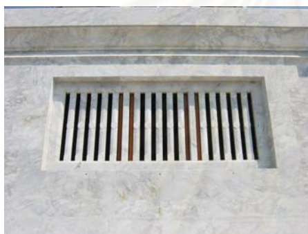
รูปที่ 4.2.6-12 ช่องหน้าต่างทำเป็นรูกลวงแบบอกเลา ทำกรอบเซ็ดหน้าปูนออกจากผนัง ด้านหลังที่รูกลวงซ้อนด้วยหน้าต่างบานเพี้ยม
