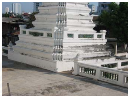
รูปที่ 4.1.5-19 องค์ประกอบในส่วนฐานแบ่งเป็น 2 ชั้น ชั้นล่าง เป็นฐานสิงห์ตั้งบนฐานเขียงอีกชั้นหนึ่ง เหนือจาก ฐานส่วนนี้เป็นเสาหัวเม็ดและพนักกระเบื้อง ส่วน ฐานชั้นบนเป็นฐานที่ต่อเนื่องมาจากเรือนธาตุ ของพระปรางค์ลักษณะเป็นฐานสิงห์ย่อมุมไม้ ยี่สิบซ้อนกัน 7 ชั้น
