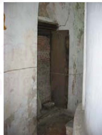
รูปที่ 4.1.6-13 ช่องประตูทางเข้าเดิม ปัจจุบันถูกปิดโดย ทำเป็นที่ประดิษฐานรูปหล่ออดีตเจ้าอาวาสแทน
