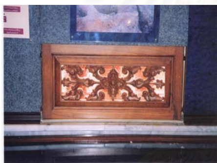
รูปที่ 4.2.5-42 ลายฉลุไม้แทรกอยู่ระหว่างบอร์ดจัดแสดง ช่วยในการระบายอากาศ
