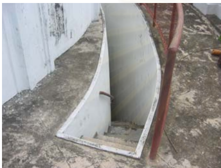
รูปที่ 4.1.3-12 บันไดทางขึ้นสู่ลานประทักษิณรอบพระเจดีย์ประธาน บันไดมีความกว้างประมาณ 60 ซม.
