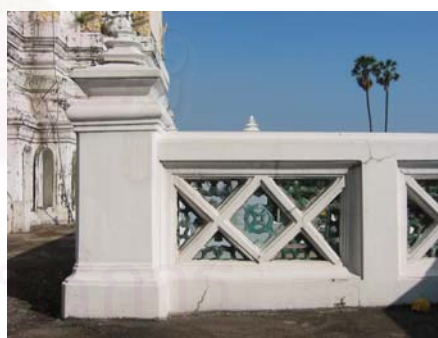
รูปที่ 4.1.5-17 เสาหัวเม็ดของฐานไฟที่ชั้นบนมีลักษณะเช่นเดียวกับชั้นล่าง แต่ในส่วนพนักกระเบื้องประดับด้วยกระเบื้องปูสีเขียวโดยนำมาประกอบกันในลักษณะของลายราชวัตร
