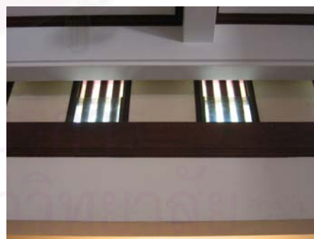
รูปที่ 4.2.5-39 ช่องเปิดบริเวณเหนือส่วนจัดแสดงพิพิธภัณฑสถาน ออกแบบให้เป็นช่องแสงและระบายอากาศ พร้อมทั้งสามารถป้องกันฝนได้ด้วย
