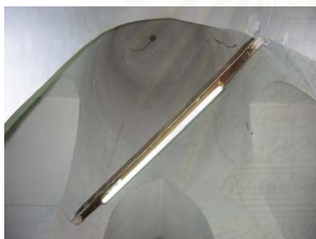
รูปที่ 4.1.6-36 ผนังรับน้ำหนักที่ทำรูปทรงแบบโค้งแหลมช่วย ในการถ่ายน้ำหนักของส่วนยอดพระเจดีย์
