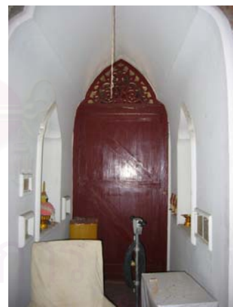
รูปที่ 4.1.8-29 ช่องคูหา ด้านหลังพระพุทธรูป แกะสลักไม้เป็นลวดลายโปร่ง ระบายอากาศได้
