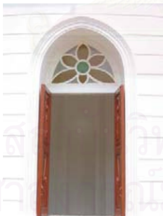
รูปที่ 4.1.9-21 หน้าต่างทรงโค้งกลม ตัวบานไม้ทำลวดลาย แบบตะวันตก เหนือส่วนบานหน้าต่าง ประดับด้วยกระจะสีรูปดอกไม้ 5 กลีบ มีเกสรสีเขียว กลีบดอกสีเหลือง
