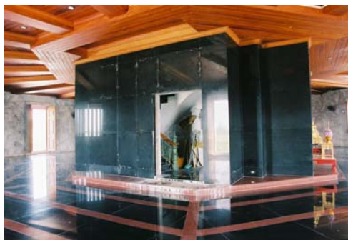
รูปที่ 4.2.6-5 ห้องควบคุมไฟฟ้าและช่องบันได ด้านหลังที่ ประดิษฐานรูปหล่อ
