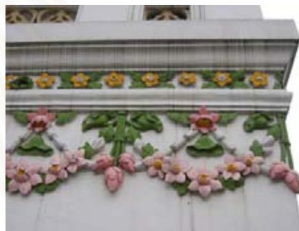
รูปที่ 4.1.6.21 ลายเฟืองระย้าปูนปั้น บริเวณได้บัวหางของฐานชั้นที่ 2
