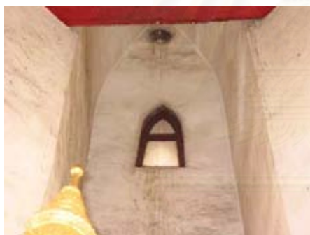
รูปที่ 4.1.5-46 ช่องระบายอากาศขนาดใหญ่ที่ผนังในระดับต่ำลงมาของพระปรางค์บิวาร
