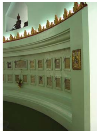
รูปที่ 4.2.1-28 แสงจากหลอดฟลูออเรสเซนต์ ซึ่งให้แสงจากทางด้านหลังกระจก เป็นการประดับไปในตัวด้วย
