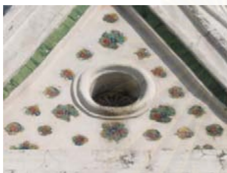
รูปที่ 4.1.5-44 ช่องระบายอากาศที่หน้าบันของพระปรางค์บิวาร
