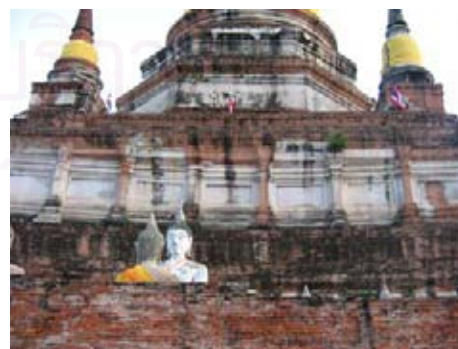
รูปที่ 3.7.14 ฐานไพทีขนาดใหญ่ ในส่วนท้องไม้ประดับด้วยเสาเก็จ เพื่อผลทางรูปด้านให้มีเส้นตั้งลดทอนความยาวของเส้นนอนของฐาน และอาจเป็นการทำขึ้นเพื่อผลทางโครงสร้างด้วย โดยทำเสาเอ็นเป็นระยะเพื่อเสริมความแข็งแรงของผนังที่มีความสูง
