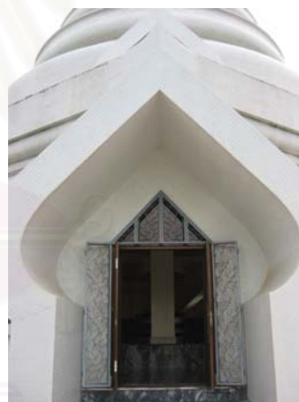
รูปที่ 4.2.3-11 ซุ้มประตูของฐานชั้น 2 เป็นซุ้มแบบที่ไม่มีรอยระกาและหางหงส์
