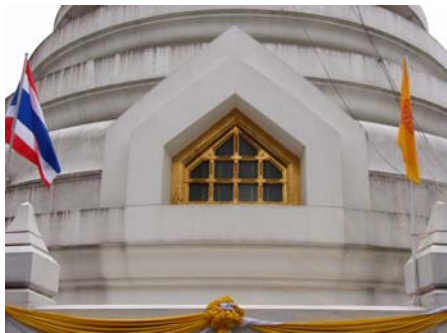
รูปที่ 4.2.1-12 ชุ่มช่องแสง ส่วนที่เป็นหน้าบ้านทำเป็นช่องแสงแทนการประดับลวดลาย
