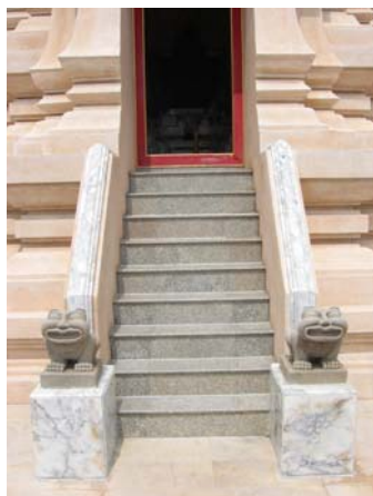
รูปที่ 4.2.5-20 พนักบันไดเป็นหินอ่อนสีขาว ชั้นบันไดวัสดุเป็นหินแกรนิตสีเทา ส่วนพื้นลานประทักษิณใช้หินทรายสีชมพู
