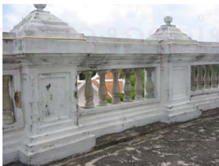
รูปที่ 4.1.3-34 พนักและเสาหัวเม็ดบนลานประทักษิณชั้นบน มีการตกแต่งเช่นเดียวกับส่วนระเบียงคด
