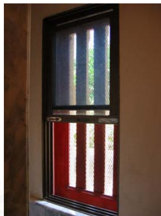
รูปที่ 4.2.5-41 ช่องเปิดบริเวณผนังในส่วนจัดแสดง ด้านนอกเป็นลูกกรงแบบอกเลา ด้านในเป็นหน้าต่างบานเลื่อน
