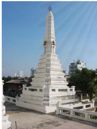
รูปที่ 4.1.5-4 พระปรางค์บริวารบนฐานไฟที่ชั้นล่างด้านทิศตะวันตก
