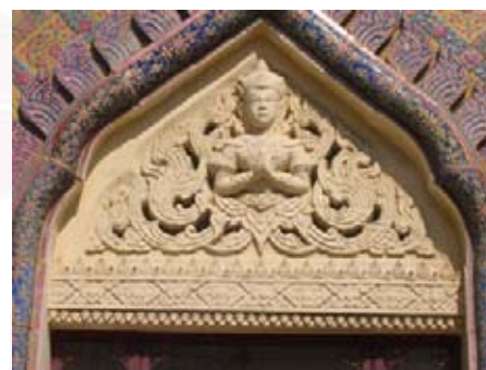
รูปที่ 4.1.8-17 หน้าบัน ประดับด้วยปูนปั้นรูปเทพพนมและลายกนก
