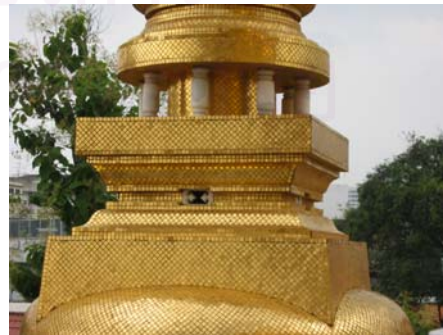
รูปที่ 4.2.7-31 ช่องระบายอากาศในส่วนบัลลังก์
