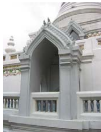
รูปที่ 4.1.6-19 ชุ่มจะระนำ ยื่นต่อออกมาจากส่วนบันไดขึ้นสู่ชั้นบน มีชุ่มทางด้านทิศเหนือและทิศใต้
