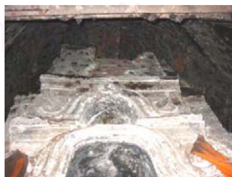
รูปที่ 3.7.10 แกนรับน้ำหนักส่วนยอดของพระเจดีย์องค์กลาง
