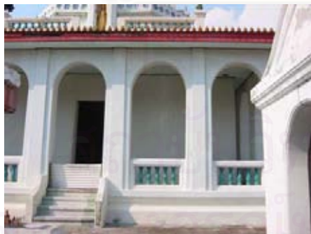
รูปที่ 4.1.2-41 เสาระเบียงและโครงสร้างในส่วนหลังคา ทำหน้าที่เหมือนเป็นคานารัดรอบผนังห้อง ในส่วนบน
