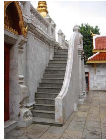
รูปที่ 4.2.7-5 บันไดภายนอกที่ขึ้นไปสู่ส่วนฐานชั้นที่ 2
