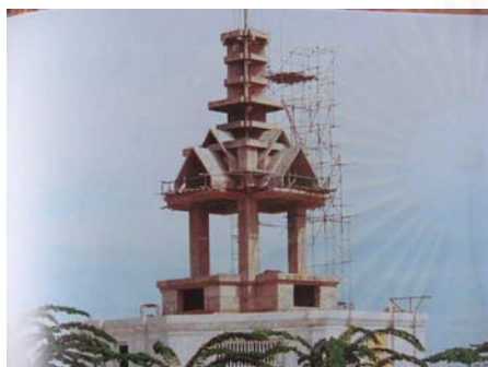
รูปที่ 4.2.6-33 ภาพถ่ายพระเจดีย์ขณะทำการก่อสร้าง แสดงลักษณะโครงสร้างในส่วนห้องพระทันตธาตุ และส่วนยอด
