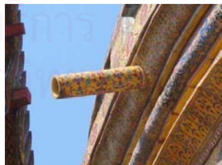
รูปที่ 4.1.8-23 ท่อระบายน้ำจากกระเบื้อง ประดับด้วย กระเบื้องเบญจรงค์
