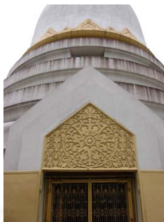
รูปที่ 4.2.1-13 ชุ่มประตูทางเข้า ปัจจุบันมีการทำเหล็กตัดเป็นลวดลายมาติดในส่วนที่เป็นช่องแสงเดิม
