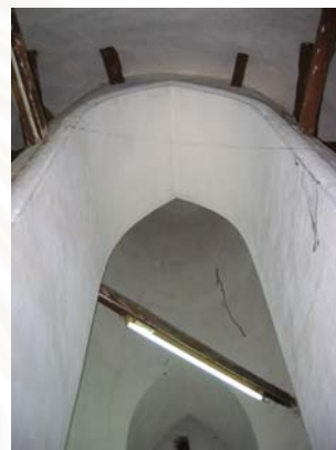
รูปที่ 5.8.2 การใช้ไม้มาช่วยในการรับแรงของส่วนผนังโค้งในพระเจดีย์วัดปทุมวนาราม
