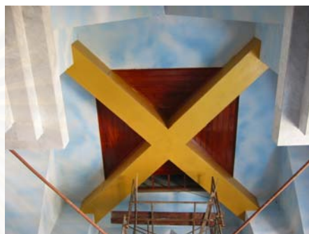
รูปที่ 4.2.6-34 คานที่รับน้ำหนักจากส่วนยอดพระเจดีย์
