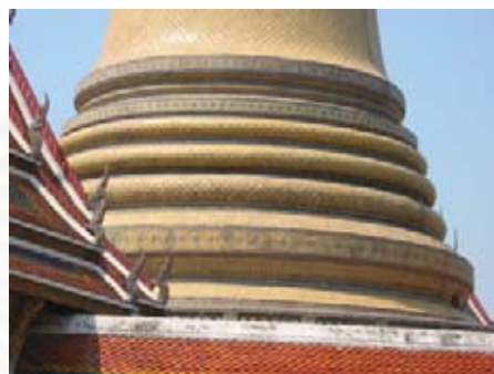
รูปที่ 4.1.8-25 การประดับในส่วนฐานบัวมัลลิกา และบัวรับองค์ระฆัง
