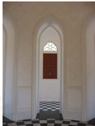
รูปที่ 4.1.9-39 หน้าหนักในส่วนยอดพระเจดีย์นั้นถูกถ่ายลงมาตามเสาที่อยู่ภายใน ส่วนโครงสร้างที่เป็น Barrel -Vault ของทางเดิน เป็นเสมือนเข็มขัดช่วยรับแรงถึบที่มาจากส่วนยอดอีกที
