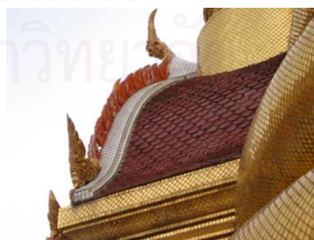
รูปที่ 4.2.7-25 หลังคามุขทางเข้าทำด้วยปูนปั้นทาสีเลียนแบบกระเบื้อง
