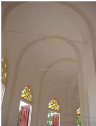
รูปที่ 4.1.9-38 Barrel -Vault บริเวณทางเดินรอบ มีเหล็กเส้น เพื่อช่วยรับแรงดึงและยึดโครงสร้าง
