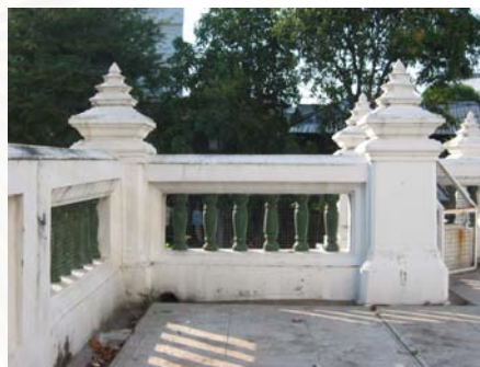
รูปที่ 4.1.5-15 เสาหัวเม็ดของฐานไฟที่ชั้นล่างเป็นเสาหัวเม็ดแบบบัวลูกแก้วอกไก่ แต่ในส่วนหน้ากระดานของหัวเสามีขนาดเล็ก และมีบัวลูกแก้วก่อนหนึ่งชั้นก่อนที่จะขึ้นเป็นหัวเสา ส่วนพนักกระเบื้องเป็นลูกกรงเซรามิคสีเขียว
