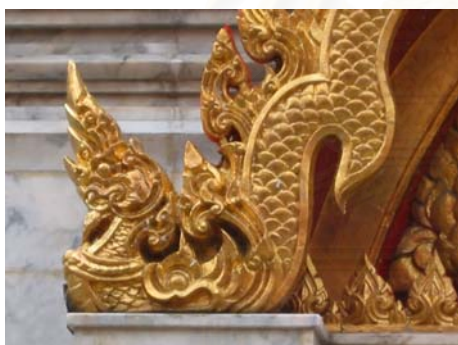
รูปที่ 5.5.3 องค์ประกอบในส่วนหน้าจั่วของซุ้มหน้าต่างที่ พระเจดีย์วัดศรีเทพ เป็นการหล่อ คอนกรีตเสริมเหล็กแบบถอดพิมพ์
