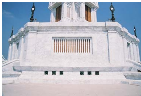
รูปที่ 4.2.6-11 ส่วนฐานชั้นที่ 1 ล่างสุดเป็นฐานบัวทึบเจาะช่องระบายอากาศ บนสุดเป็นชั้นบัวหงาย
