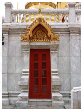
รูปที่ 4.2.7-11 ซุ้มประตู ตัวบานทำเป็นบาน 2 ชั้น ชั้นในเป็นบานอกเลาแบบไทย บานชั้นนอกลูกฟักเป็นกระจุก เป็นบานเปิดออกเพื่อกันฝนเข้าอาคาร
