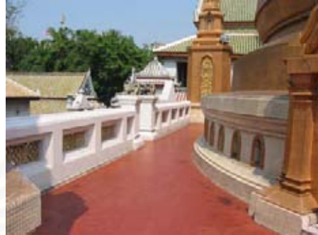
รูปที่ 4.1.4-21 ลานประทักษิณชั้นบน
