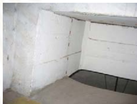
รูปที่ 4.1.6-37 คานคอนกรีตเสริมเหล็ก รับน้ำหนักในส่วน พระพุทธรูปปางไสยาสน์ ซึ่งน่าจะเป็นการ ทำชั้นภายหลัง
