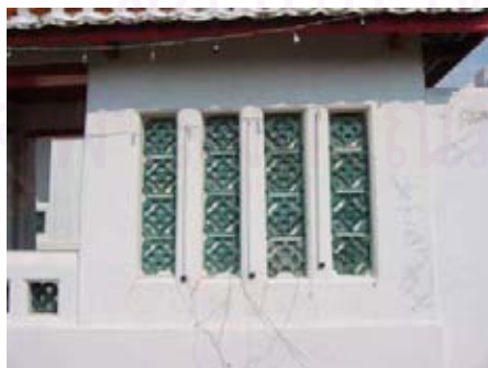
รูปที่ 4.1.2-30 กระเบื้องปูลิเซียประดับที่ผนัง สังเกตว่าไม่ได้ทำขึ้นเพื่อระบายอากาศเพราะมีการก่อปูนซ้อนด้านหลัง
