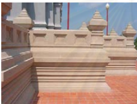
รูปที่ 4.2.4-11 ฐานประทักษิณชั้น 2 เป็นฐานปัทม์ ที่ท้องไม้เดินเส้นลวดบัว 5 เส้น, ผนังกระเบื้องทำเป็นลูกฟักเรียงกัน 3 ช่อง
