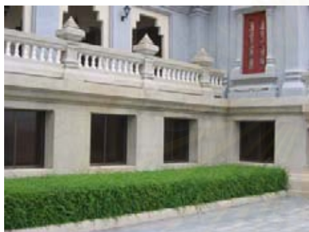
รูปที่ 4.2.8-32 ส่วนของฐานปัทม์มีวทรายล้าง
