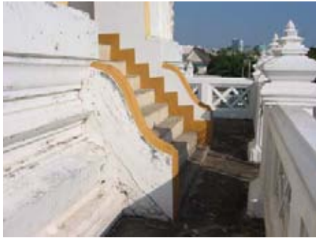
รูปที่ 4.1.5-2 ลานของฐานไฟที่ชั้นบนที่เชื่อมต่อกับบันไดของพระปรางค์ประธาน จะเห็นว่าพื้นที่คอนกรีตแคบ ดังนั้นฐานในชั้นนี้ น่าจะสร้างเพื่อประโยชน์ในรูปแบบสถาปัตยกรรมมากกว่า
