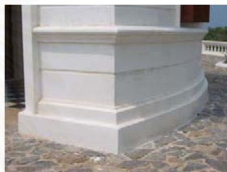
รูปที่ 4.1.9-20 ฐานชั้นล่างสุดทำบัวแบบตะวันตก ถ้าเทียบกับฐานของไทยก็คือฐานปัทม์
