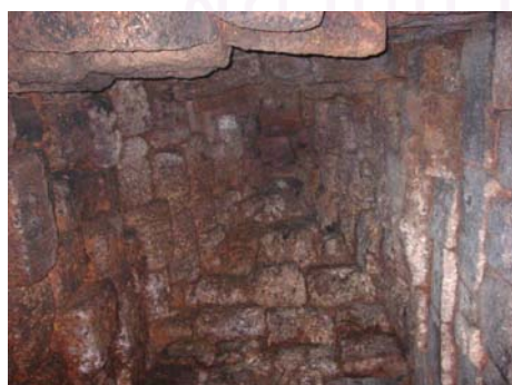
รูปที่ 3.5.7 ภายในปราสาทขอม ในภาพแสดงการก่อศิลาแลงเป็นส่วนยอดของปราสาท
