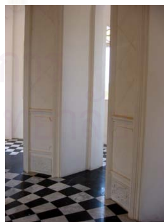
รูปที่ 4.1.9-33 จุดที่เป็นมุมของเสาหรือผนังจะประดับด้วยลวดบัว
