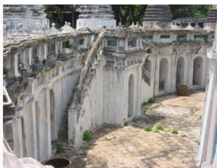
รูปที่ 4.1.3-42 พื้นที่ส่วนมากเป็นส่วนของช่องคูหา ซึ่งเปิดโล่ง จึงไม่มีปัญหาทั้งการระบายอากาศและแสงสว่าง
