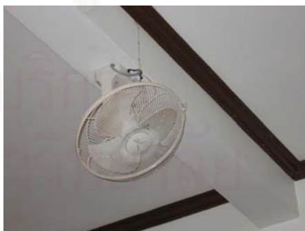
รูปที่ 4.2.5-45 เมื่อเวลามีคนมาใช้งานจำนวนมากจะต้องอาศัยพัดลมช่วยในการไหลเวียนของอากาศ
