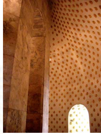
รูปที่ 4.1.4-37 ผนังภายในพระเจดีย์ ซ้ายมือของภาพคือเสารับน้ำหนักจากยอดเจดีย์ประดับด้วยหินอ่อน
