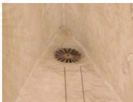
รูปที่ 4.1.5-45 ช่องระบายอากาศที่เจาะทะลุเข้ามาสู่ภายในพระปรางค์
