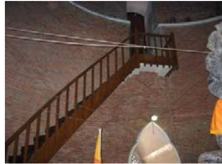
รูปที่ 4.1.8-9 บันไดไม้ภายในใช้ขึ้นไปบนระเบียงเพื่อใช้ซ่อมแซม ไฟส่องอาคาร ซึ่งเป็นการทำเพิ่มเติมขึ้นภายหลัง
