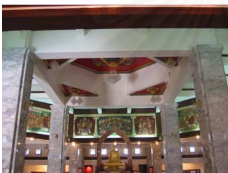
รูปที่ 4.2.5-46 การเปลี่ยนโครงสร้างจากผนังรับน้ำหนักเป็นแปดเหลี่ยม
