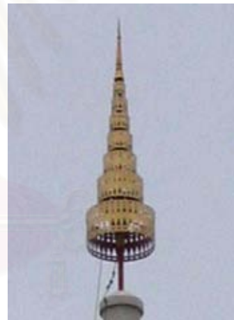
รูปที่ 4.2.1-19 ลายฉลุโลหะที่ฉัตร 7 ชั้นบนยอดพระเจดีย์
