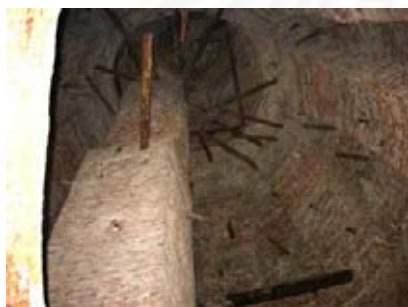
รูปที่ 5.8.1 โครงสร้างภายในของพระเจดีย์วัดประยุรวงศาวาส ใช้ไม้เป็นตัวค้ำยันและยึดโครงสร้างผนัง
