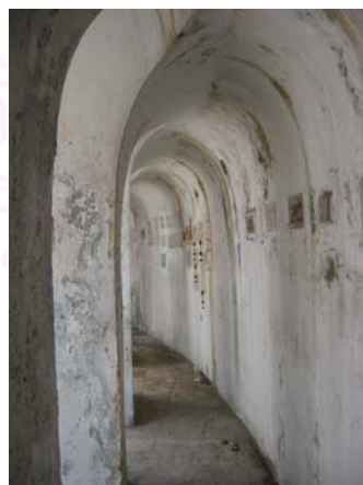
รูปที่ 4.1.3-44 โครงสร้าง Barrel-Vault ในส่วนของระเบียงคดชั้นใน
