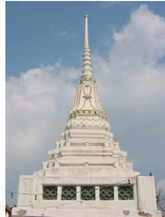
รูปที่ 4.1.2-27 พนักประดับด้วยกระเบื้องปูลิเซีย
