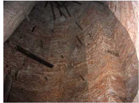
รูปที่ 4.1.3-46 ผนังค้ำยันทำหน้าที่เสมือนเสาด้านข้าง ซึ่งโค้ง ไปบรรจบกันที่บริเวณเชิงองค์ระฆัง ช่วยรับ น้ำหนักจากส่วนยอด
