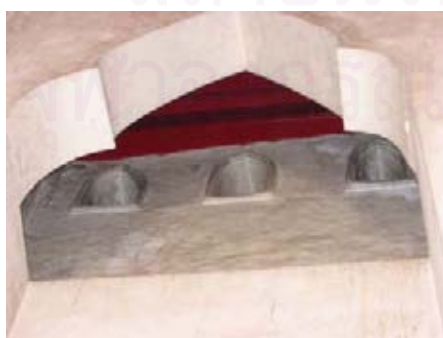
รูปที่ 4.1.5-48 ช่องระบายอากาศที่เห็นจากภายในพระปรางค์ประธาน
