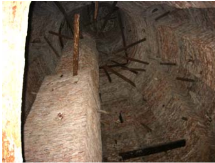
รูปที่ 4.1.3-45 โครงสร้างภายในองค์พระเจดีย์ ใช้ไม้เป็นตัวค้ำยัน และยึดโครงสร้างผนัง เสากลางที่รับน้ำหนักจาก ยอดเจดีย์ในระดับล่างมีผนังเป็นสี่เหลี่ยมจัตุรัส แต่ ในระดับที่สูงขึ้นไปมีผนังเป็นแปดเหลี่ยม เพราะ ต้องเพิ่มพื้นที่ระนาบตั้งฉากให้กับไม้ที่ค้ำยัน
