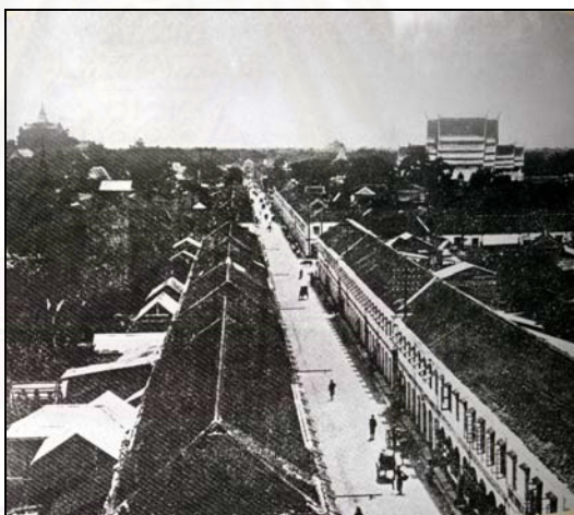
ภาพที่ 5.11 การตั้งถิ่นฐานไปตามถนน
