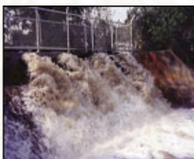
ภาพที่ 3.15 ระบบการป้องกันน้ำท่วม
