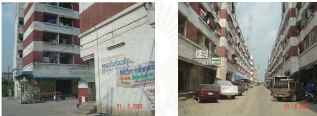
ภาพที่ 4.35 - 4.36 พรอนันต์คอนโดมิเนียม
