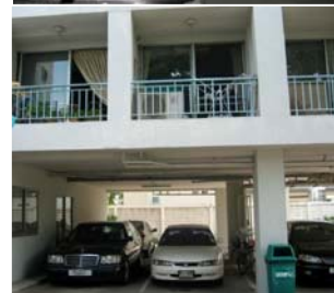
รูปที่ 4.1 รูปอาคาร A
