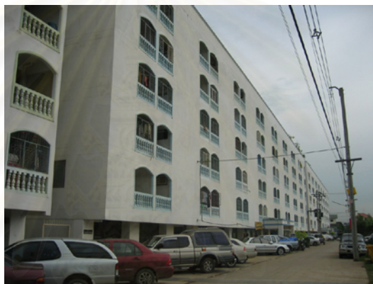
รูปที่ 1.1 ที่จอดรถที่ใช้ช่วงระยะถอยร่นของอาคารจากถนนหน้าโครงการ
