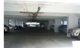
รูปที่ 4.4 รูปอาคาร D
