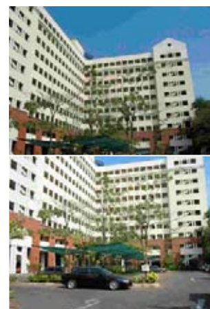
รูปที่ 4.3 รูปอาคาร C
