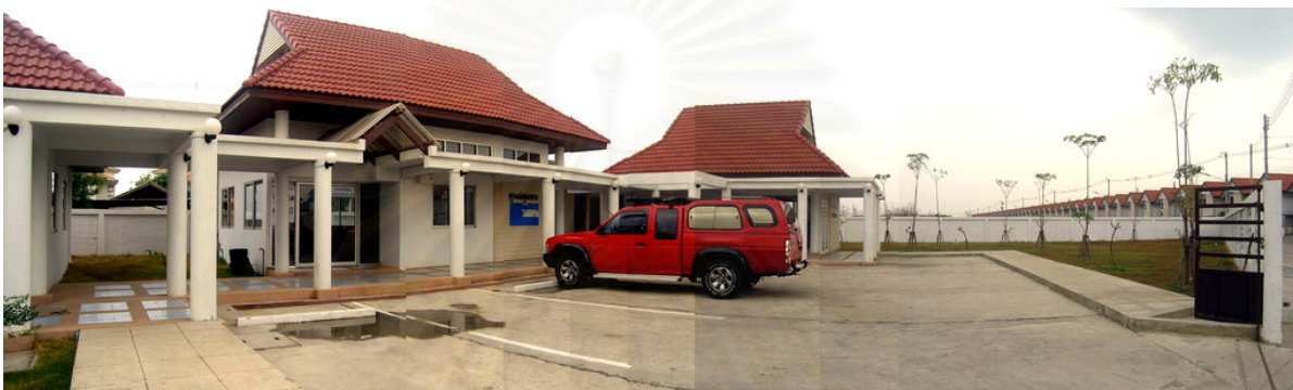
ภาพที่ 4.36 ลานจอดรถในบริเวณศูนย์ชุมชนโครงการบ้านเอื้ออาทรรังสิตคลองสาม (บันทึกภาพวันที่ 26 มกราคม 2548 เวลา 13.44 น.)
