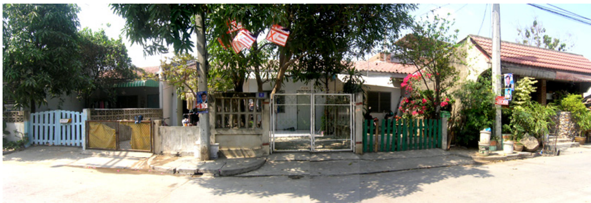
ภาพที่ 4.74 การดัดแปลงต่อเติมรั้วเดิม (บันทึกภาพวันอาทิตย์ที่ 6 กุมภาพันธ์ 2548 เวลา 12.43 น.)
