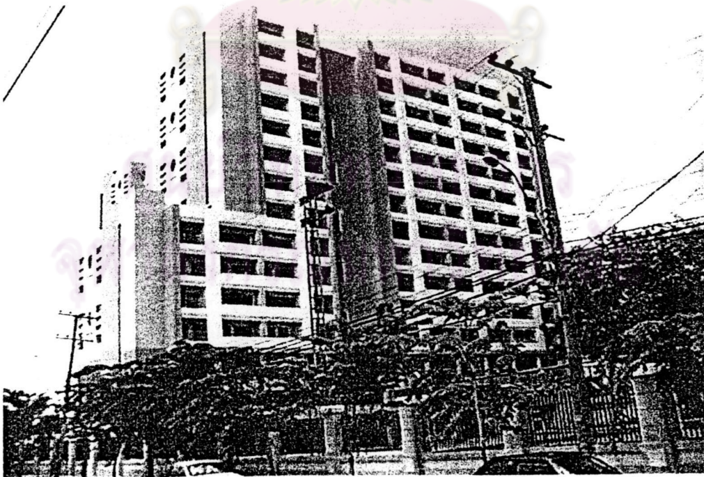
รูปที่ 3.7 ภาพถ่ายอาคารด้านข้าง
