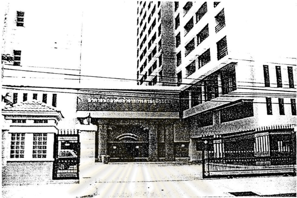
รูปที่ 3.10 ทางเข้าด้านหน้าและป้อมยาม
