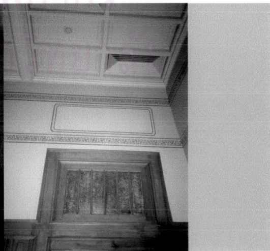
รูปที่ 3-55 ภาพแสดงหัวจ่ายแอร์แบบสี่เหลี่ยมที่กลมกลืนกับฝ้าเพดานภายในพิพิธภัณฑ์ธนาคารแห่งประเทศไทย
