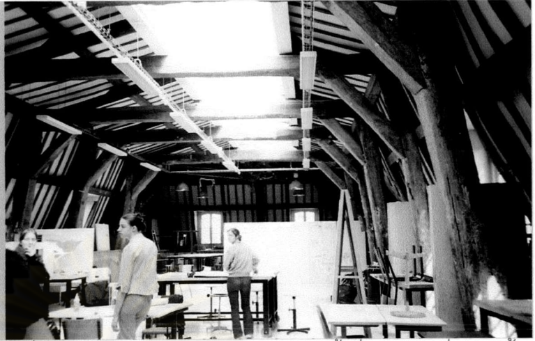
รูปที่ 3-46 ภาพแสดงการดัดแปลงโครงหลังคาใหม่ของแสงทะลุผ่านจากดานบนที่อาคารสถาบันสถาปัตยกรรมแห่งแวร์ซายน์
