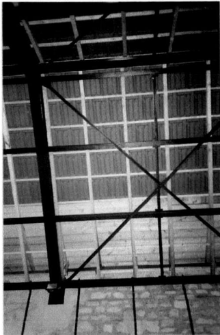
รูปที่ 3-45 ภาพแสดงการเสริมโครงเหล็กเดิมด้วยเหล็กที่ยาน Bercy ซึ่งแต่เดิมเป็นโรงเก็บไวน์, ประเทศฝรั่งเศส
