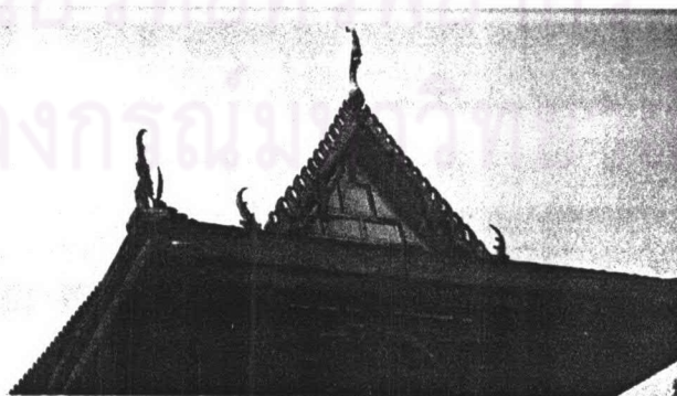
ภาพที่ 5.18 หลังคาหอพระไตรปิฎกวัดระฆัง เป็นหลังคาชั้นเดียวและมีกันสาดยื่นยาว
