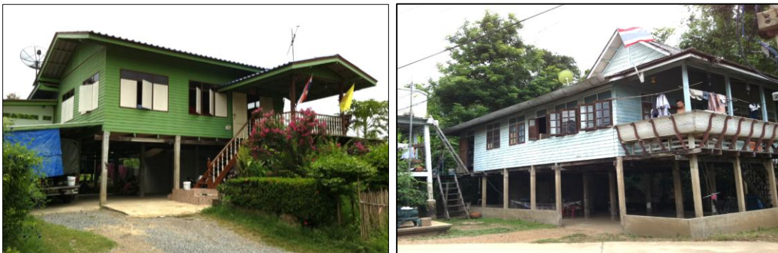
ภาพที่ 3-63 และ 3-64 ที่อยู่อาศัยสองชั้นแบบชั้นล่างกึ่งเปิดโล่ง ในชุมชนหัวเวียง
