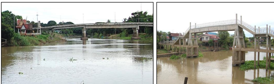
ภาพที่ 3-35, และ 3-36 สะพานวัดหัวเวียง และสะพานวัดบางกระทิง
