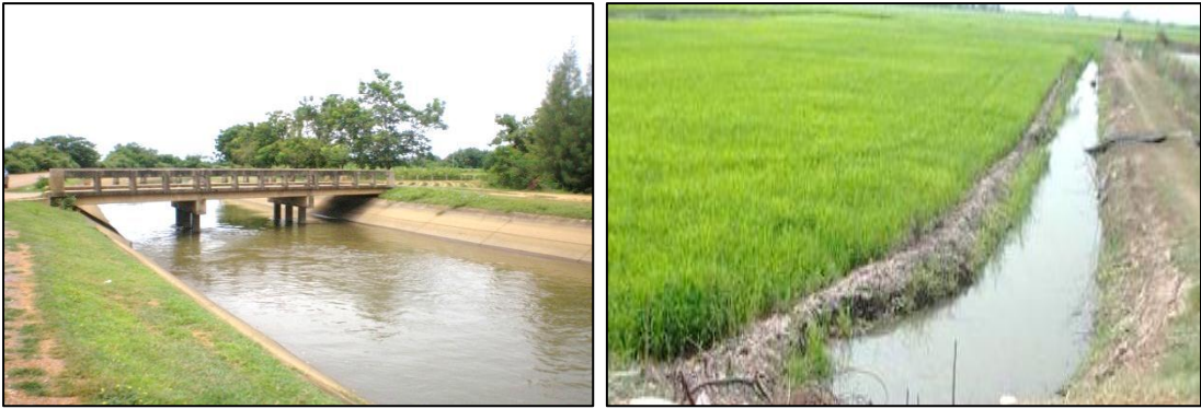
ภาพที่ 3-21 และ 3-22 คลองส่งน้ำชลประทานผักไห่-เจ้าเจ็ด และ คลองลำประโดงส่งน้ำเข้านา
