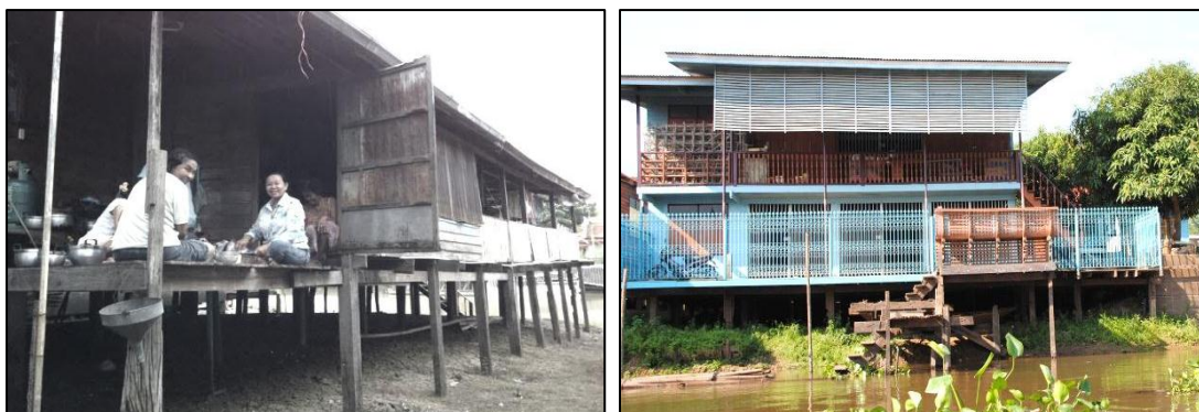
ภาพที่ 4-5 และ 4-6 ที่อยู่อาศัยยกพื้นไม่สูง กรณีเป็นที่อยู่อาศัยสองชั้นแบบชั้นล่างเปิดโล่ง และกรณีเป็นที่อยู่อาศัยสามชั้นแบบชั้นล่างเปิดโล่ง ที่มา : ผู้วิจัย, มีนาคม 2554.
