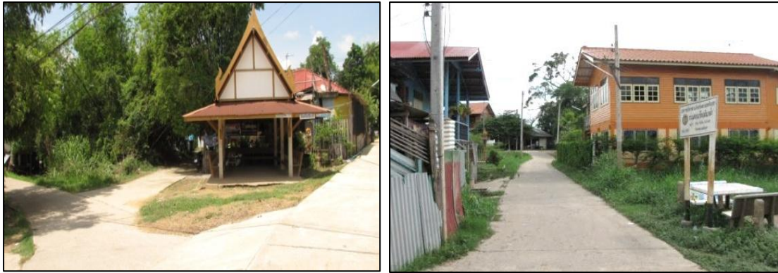
ภาพที่ 3-29 และ 3-30 ถนนวงแหวนบริเวณแยกไผ่วง และถนนวงแหวนหัวเวียง ซอย 4
