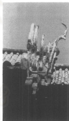
ภาพ 4-30 การใช้วัสดุประเภทโลหะหุ้มหัวแป หลังจากการตัดส่วนที่ผุออกต่อใหม่แล้ว
