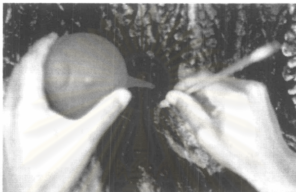
ภาพ 4-23 ภาพ การทำ ความสะอาดและซ่อม แซมปูนปั้น ลุกสี แดงที่เห็นคือลูก บิ๊บ
