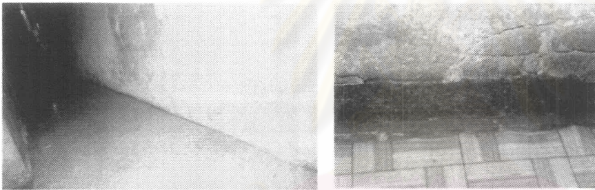
ภาพ 3-101 ซ้ำย การปู เสื่อน้ำมันทับกระเบื้องยุค รัตนโกสินทร์ ชาว ความ เสียหายจากความชื้นจาก ดินที่ฐานผนัง
