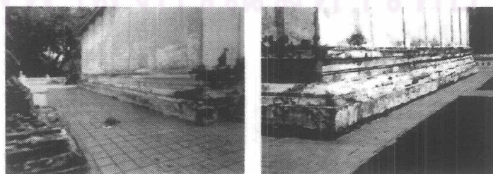
ภาพ 3-81 ฐานอาคาร ปรากฏความเสียหาย และศรทบควมซึนมาก กว่าบริเวณอื่น
