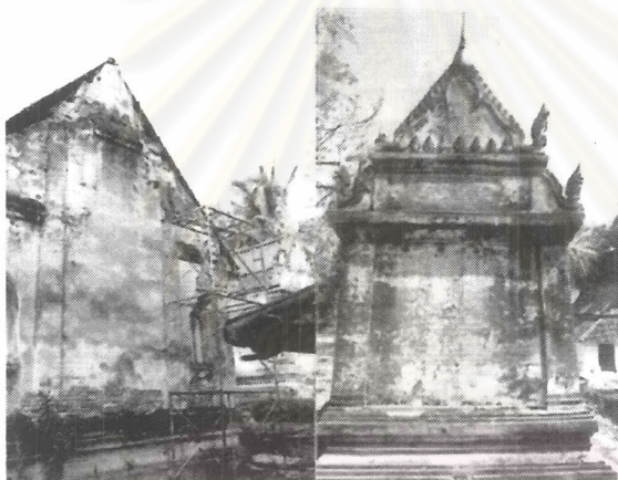
ภาพ 3-51 ความเสียหายจากการสาดไล่ของน้ำฝนบนผนังด้านสกัดซึ่งไม่มีไซราเกิดเป็นคราบดำทั่วทั้งผนัง
