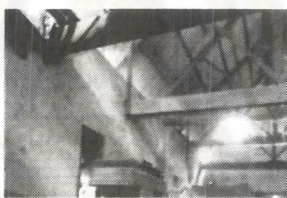
ภาพ 3-177 ภาพแสดงการ วางซ็อนเข้าผนังแบบซ็อนทะลุ
