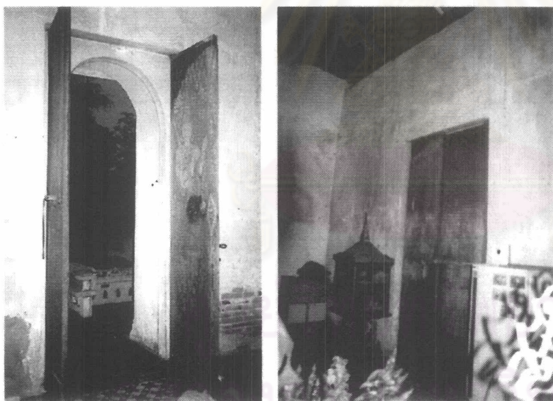
ภาพ 3-108 ภาพประตูแบบบาน ฝังริมผนังซึ่งในปัจจุบันเชื่อว่าไม้ ธรรณีได้ถูกเปลี่ยนเป็นคอนกรีต แล้ว(?) ส่วนโค้งประตูเป็นโค้ง ครึ่งวงกลม ซ้ายเป็นประตูหน้า ขวา เป็นประตูหลัง
