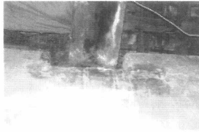
ภาพ 3-113 ซ้ายโครง หลังคาส่วนล่างขวา ภาพขยายแสดงการ วางข้อแบบฝังผนัง มี คราบความชื้นอยู่
