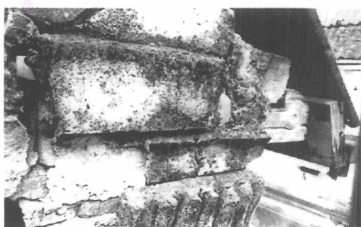
ภาพ 3-140 2ภาพซ้ายเป็นโพรงที่โครงประตูเสริมในหน้าบ้านกลางหายไป ขวาสุด รอย บากผนังรับแปของส่วนชั้นลดแทนการเสริมจันทัน
