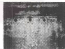
ภาพ 3-199 ระบาย อากาศรูปกากบาท บริเวณใต้บัวยอด ผนัง มีอยู่ตลอดรอบ อาคาร
