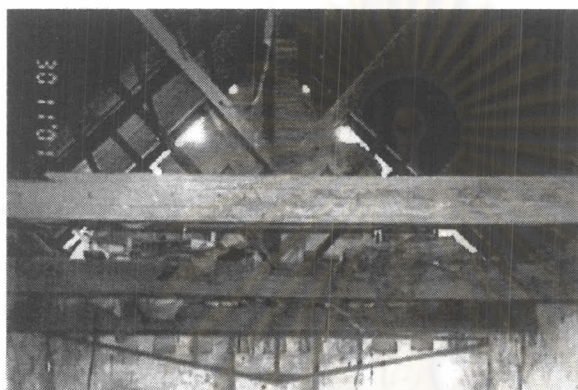
ภาพ 3-175 รอยบากผนังบ้านเพื่อ วางแป ทำให้ทราบว่าโครง ประดิวหารคดลึงมีเพียง 4 ซ็อนน้อยกว่าหลังอื่นอยู่ 1 ชั้น และ รอยบากเฉียง 2 ซ้าง ทำให้ทราบว่ามีการ ใช้จันทันชั้นลด
