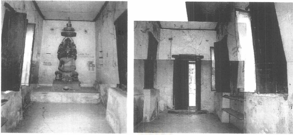
ภาพ 3-210 ซ้าย สภาพภายในอาคารเมื่อเช้า มีแท่นก่อ ปัจจุบันตั้งพระพุทธรูป ซึ่งบังช่องกุดแหลมด้านหลังได้ ซ้าย-ขวามีช่องลักษณะเดียวกันอยู่ รวมเป็น 3 ช่อง ขวา ภาพมองย้อนกลับไปประตู เห็นแท่นก่อรองใต้ธรณีหน้า ต่าง มีการพาดไม้เป็นชั้นวางของ และติดคัทเอ้าท์ที่หลังบานประตู พื้นปูนขัดมัน เพดานตีฝ้าสมัยใหม่
