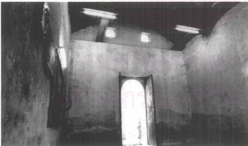
ภาพ 3-102 ผนังสกัด ตะวันออกด้านใน มีคราบ ความชื้นจากดินเป็นแนว ชัดเจนโดยขึ้นสูงและเกิด ความเสียหายมากที่สุด บริเวณช่องเปิดด้านสกัด
