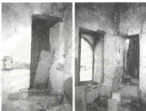
ภาพ 3-170 ซ้าย รอยสกัด ที่หน้าต่าง และขวา บาน หน้าต่างที่เปิดแสดงถึง การเสื่อมสภาพของไม้ บานสีเหลี่ยมที่ไม่เท่ากัน เกิดรอยคราบตามรูปโค้ง
