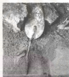
ภาพ 3-93ภาพเกรียง ฉาบปูนอาคาร
