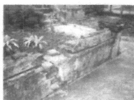
ภาพ 3-209 สภาพโดยทั่วไปของกำแพงแก้ว เฉพาะบางส่วนของด้านใต้มีการก่อสร้างปิดช่องระหว่างฐานทักษิณเพื่อทำฐานและบันไดขนาดเล็กด้วย
