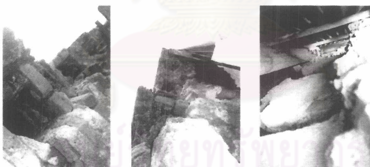
ภาพ 3-140 2ภาพซ้ายเป็นโพรงที่โครงประตูเสริมในหน้าบ้านกลางหายไป ขวาสุด รอย บากผนังรับแปของส่วนชั้นลดแทนการเสริมจันทัน
