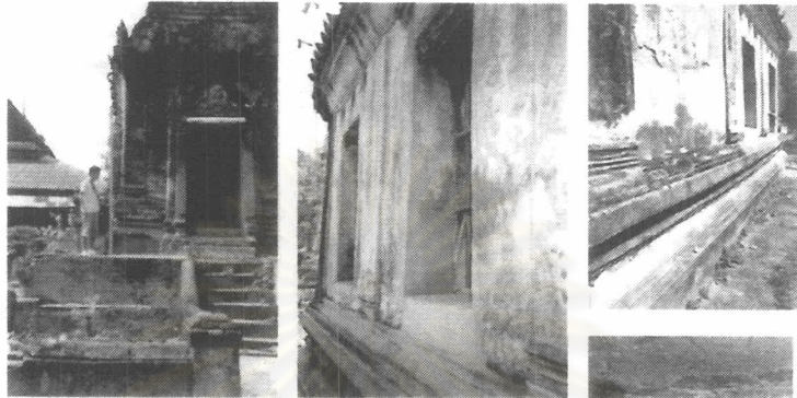
ภาพ 3-190 ซ้าย ผนังสอป แนวผนังตรงกับพระระฆังพอดี ขวา หน้าต่างทิศเหนือ ภายในช่องยังมีคราบชาดที่ทาไว้และมีร่องรอยการซ่อมด้วยปูนซีเมนต์
