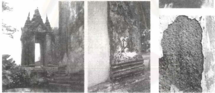
ภาพ 3-192 ซ้าย ความเสียหายจากความชื้นในผนังชัดเจนตั้งแต่ปี 2517 ขวา มีไลเคนขึ้นบนเสาแบบมูมที่เป็นทางไล่ของน้ำจากหลังคา
