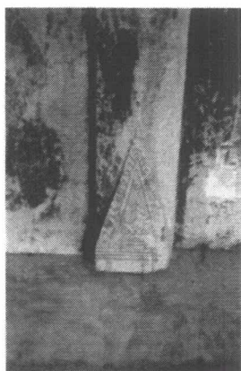
ภาพ 3-92 ส่วนล่าง ของออกเลา สิ่งเกิดความ เสียหายจากสภาพอากาศ
