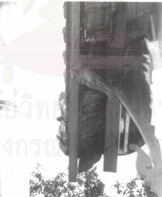
ภาพ 3-66 ภาพทวยซู่ข้าง ซ้ายเป็นภาพถ่ายปี 2517 ขวา เป็นทวยที่ได้รับการ บูรณะหรือเปลี่ยนใหม่แล้ว โดยยังคงรูปแบบเดิม แต่มี การทำน้ายารักษาเนื้อไม้จึง เห็นเป็นสีเขียว
