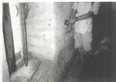
ภาพ 3-166 ซ้าย แนวระดับความขึ้น แถบตะวันตกที่มากผิดปกติ และขวา คราบความขึ้นในผนัง
