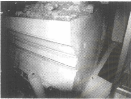
ภาพ 3-75 ภาพรอยความชื้นที่ ขึ้นถึงฐานชุกชี ในภาพเป็น คราบเหลืองด้านข้างฐาน
