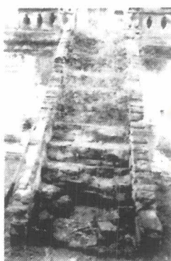
ภาพ 2-9 การถากอิฐ ราวบันได
