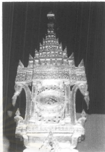
ภาพ 2-131 หัวเสาสดใน โบสถ์วัดตองปุ ลพบุรี ซ้าย ทวยช่วงล่าง แบบมอญ- พม่าซึ่งชำรุด ไปและขวา ทวยค้ำส่วน ยอดหัวเสา
