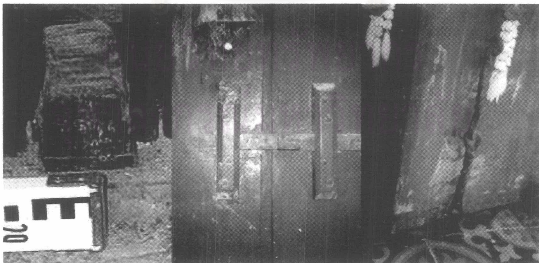
ภาพ 2-93 อุปกรณ์ประกอบประตูต่างๆ จากซ้าย กบ มือจับ และโซ่คล้องประตู
