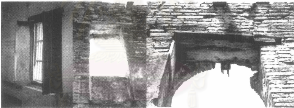
ภาพ 2-80 การถ่ายน้ำหนักลงทับหลังโดยตรงโดยไม่ใช้ธรณีแบบต่างๆ
