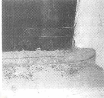
ภาพ 2-91 การใช้เหล็กรัดขอบบาน
