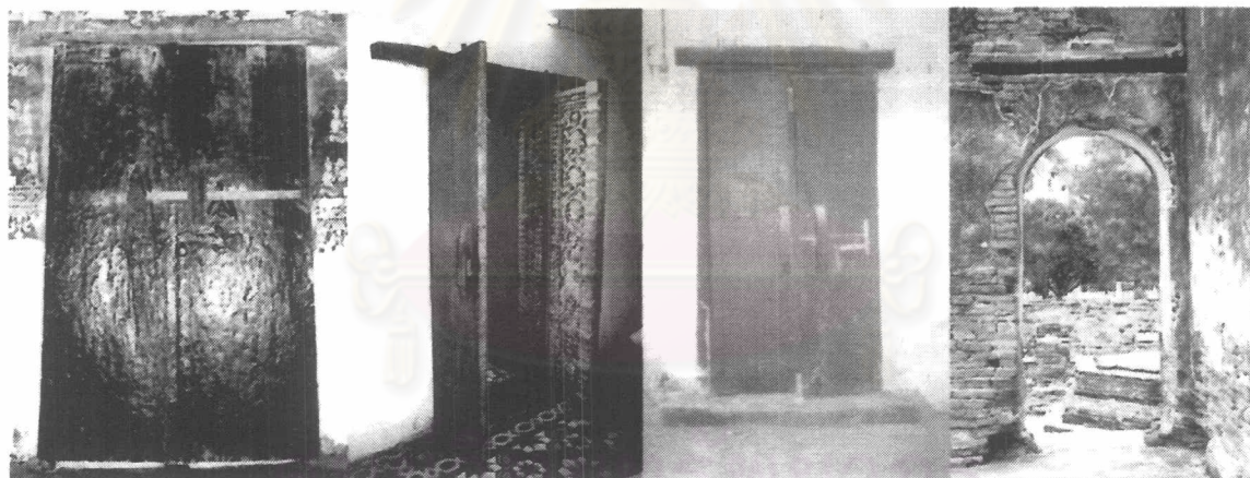
ภาพ 2-70 บานฝังนอกผนัง ตามเจ็มนาทิกา สองภาพแรกคือตัวอย่างที่ยังคงทำแพร่หลายอยู่ในเมืองหลวงพะบาง ประตูด้านในวิหารน้อยวัดตองปุ ประตูของวิหารเบื้องขวาพระประธานวัดมหาธาตุ ลพบุรี และ หน้าต่างบนผนังด้านใต้ วิหารจตุรमुखวัดพระศรีสรรเพชญ์ อยุธยา สังเกตว่าจะไม่มีเส้นกรอบสี่เหลี่ยมเกิดขึ้น
