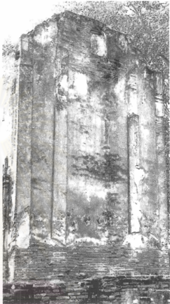
ภาพ 2-29 การใช้ปูนพอกเป็นเสานแบบโดยไม่มีอิฐก่อ
