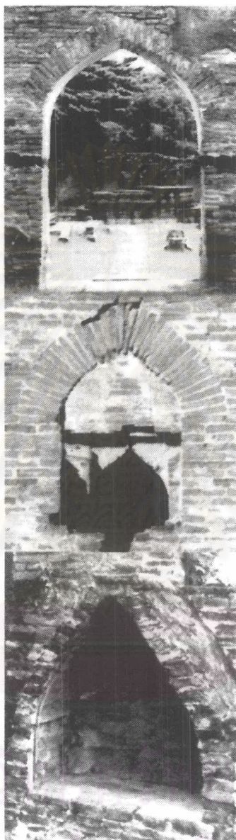
ภาพ 2-65 การเรียงสันอิฐแบบต่างๆ จากบนการเรียงแบบทำมุมขึ้น การเรียงตั้งจากกับสันโค้ง ตามลำดับ
