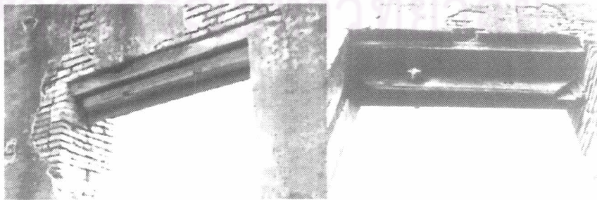
ภาพ 2-82 การใช้จำปายึด ด้านใน(ภาพซ้าย) ทะลุออกมาด้านนอก (ภาพขวา)
