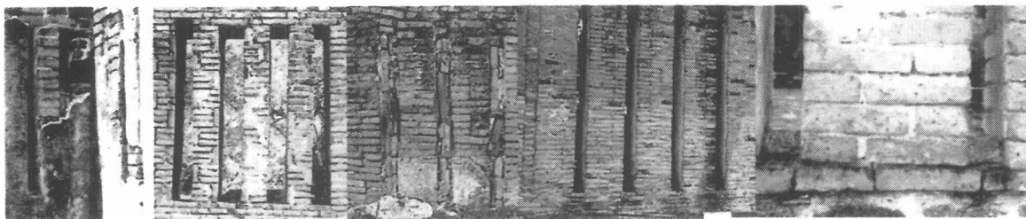
ภาพ 2-69 ตัวอย่างการเรียงอิฐลูกทรงแบบต่างๆจากซ้าย การเรียงด้านสั้นออก การเรียงผสมแนวตั้ง-นอน การเรียงเป็นแบบพันระอึง ลิซบอนด์ และ เฟลมิซบอนด์ และขวาสุด การก่อลูกปูน ตามลำดับ
