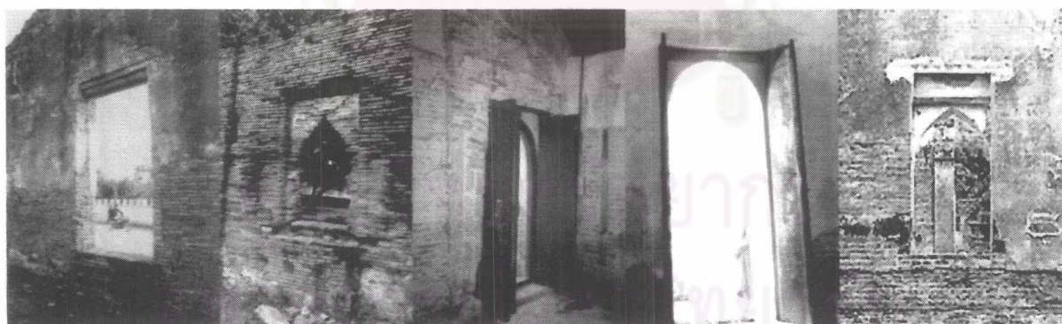
ภาพ 2-71 บานฝังริมผนัง จากซ้าย วัดสุวรรณาวาส ผนังทิศตะวันออกวิหารจตุรมุขวัดพระศรีสรรเพชญ์ อยุธยา วิหารหลวงวัดโล่ห์ วิหารมหาธาตุวัดตองปุ ลพบุรี สังเกตว่าจะเกิดร่องเป็นกรอบสี่เหลี่ยม และขวาสุด บานฝังริมผนังแยกทับหลังวิหารหลวงวัดมหาธาตุลพบุรี
