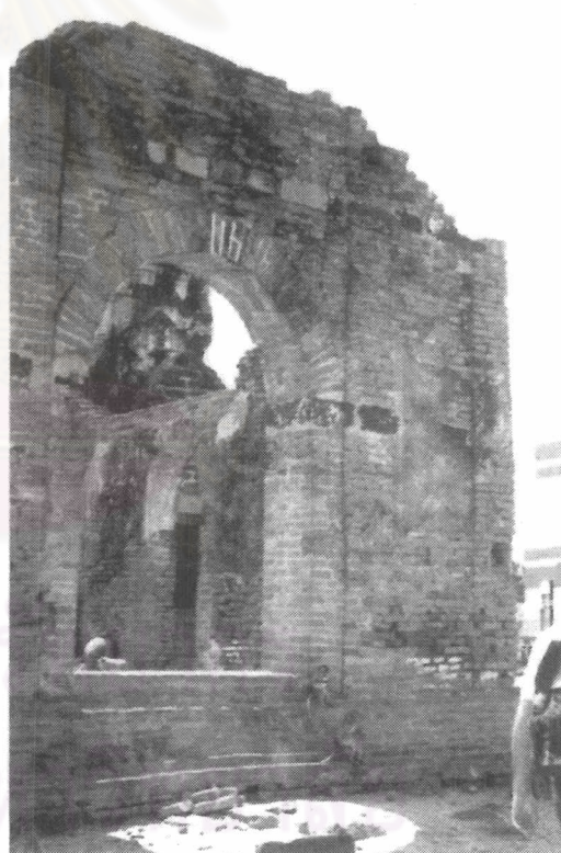
ภาพ 2-33 ภาพบน พระที่นั่งจอมทอง วัดพระศรีสรรเพชญ์ มีการใช้แลงเสริมในผนังในระดับทับหลัง ภาพล่างซ้าย วิหารหลวง วัดมหาธาตุ ลพบุรี ผนังมีการเสริมด้วยแลงที่ระดับต่ำกว่าฐานโค้ง ภาพล่างขวา วิหารพระปรางค์สามยอด ใช้แลงร่วมกับหินทรายเสริมที่ฐานโค้งและทับเหนือโค้ง
