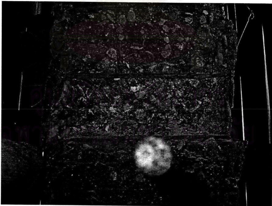
รูปที่ 4.19 เกิดการกะเทาะเข้าไปในส่วนคอนแกนคอนกรีตเล็กน้อย
