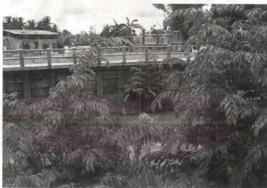
1. ท่อระบายน้ำที่ปล่อยลงสู่แหล่งน้ำธรรมชาติลำตะคองโดยตรง
