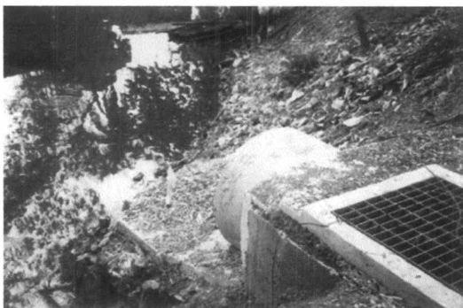
1. การต่อท่อระบายน้ำทิ้งและน้ำเสียปล่อยลงสู่แหล่งน้ำลำตะคองโดยตรง
