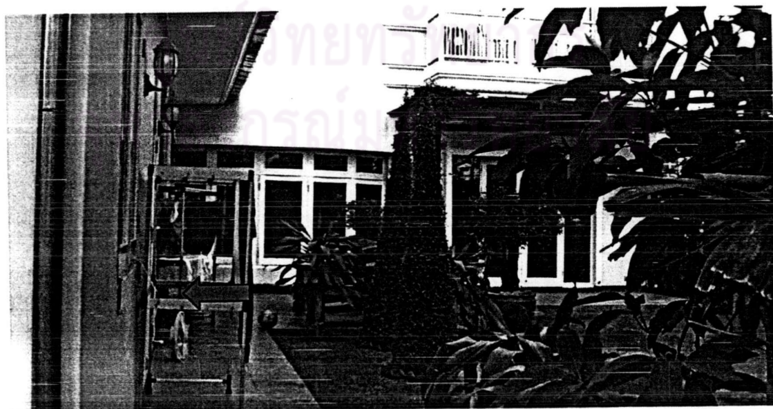
ภาพประกอบ 4.2.3 บ้านกลุ่มตัวอย่างรายชื่อที่ 1 - ส่วนต่อเติม บริเวณห้องซักรีด
