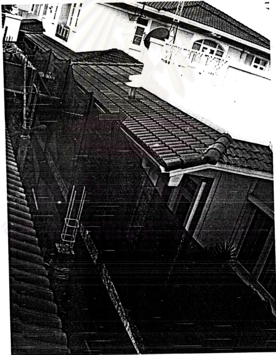
ภาพประกอบ 4.3.2 บ้านกลุ่มตัวอย่างรายชื่อที่ 2 - ส่วนต่อเติมบริเวณครัวด้านหลังบ้าน
