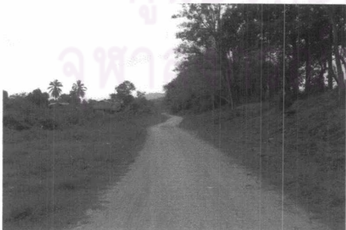
สภาพถนนรอบแนวกำแพงเมืองเชียงแสนซึ่งมีสภาพค่อนข้างชำรุด เป็นดินลูกรังทำให้ไม่สะดวกในการเดินทาง
