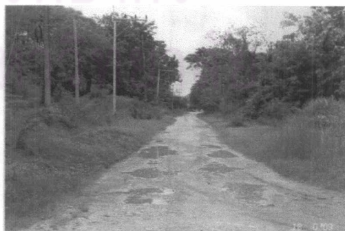
สภาพถนนรอบแนวกำแพงเมืองเชียงแสนซึ่งมีสภาพค่อนข้างชำรุด เป็นดินลูกรังทำให้ไม่สะดวกในการเดินทาง
