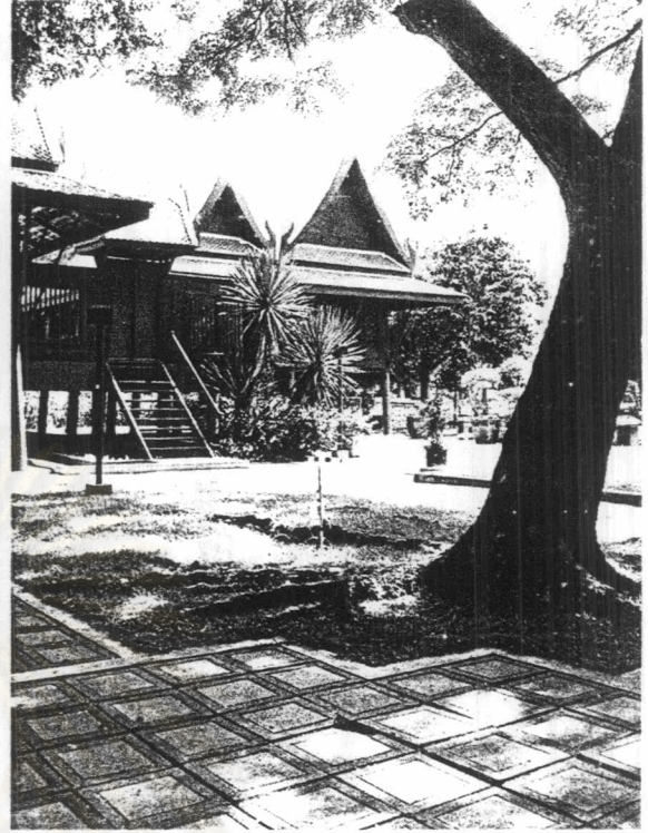
ภาพ 3.5 สภาพแวดล้อมบริเวณใต้ร่มไม้ พื้นคอนกรีต
