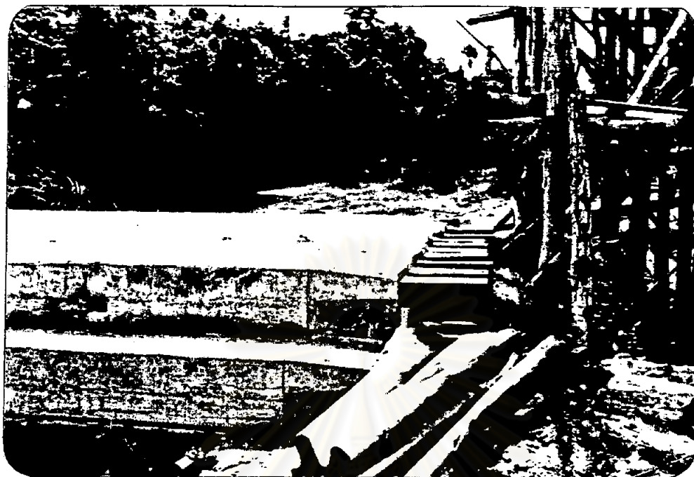
รูป 5-10 เสาค้ำที่ออกแบบสำหรับตอกจิกลงในชั้นหิน
