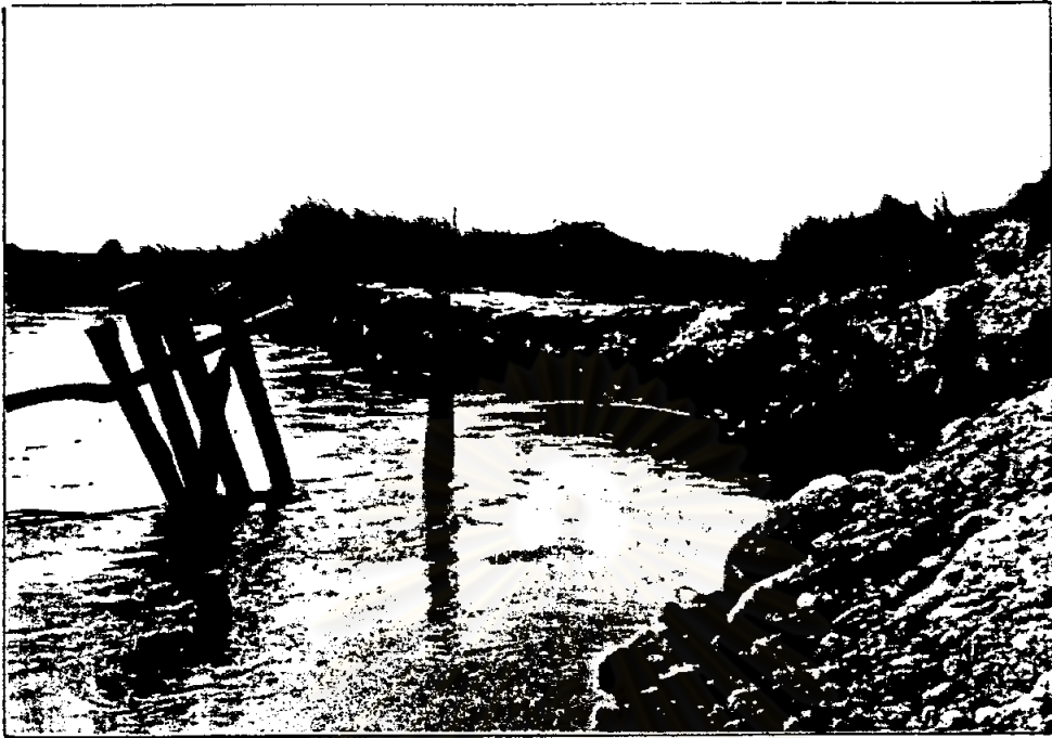
รูป 5-4 เสาค้ำที่ตีเป็นพิคตการกักเขาะ แต่ไม่ได้ผล
