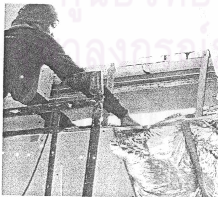
รูปที่ 3-6 แสดงการติดตั้งฉนวนใยแก้วเหนือฝ้าเพดานและการพ่นฉนวนโพลีที่พื้นอาคาร
