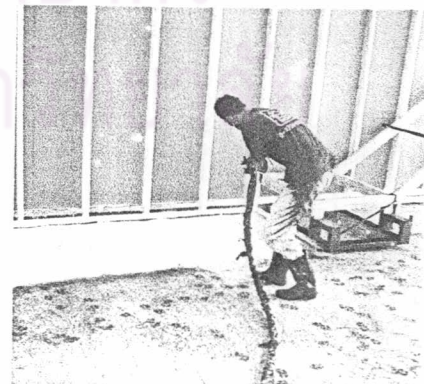
รูปที่ 3-6 แสดงการติดตั้งฉนวนใยแก้วเหนือฝ้าเพดานและการพ่นฉนวนโพลีที่พื้นอาคาร
