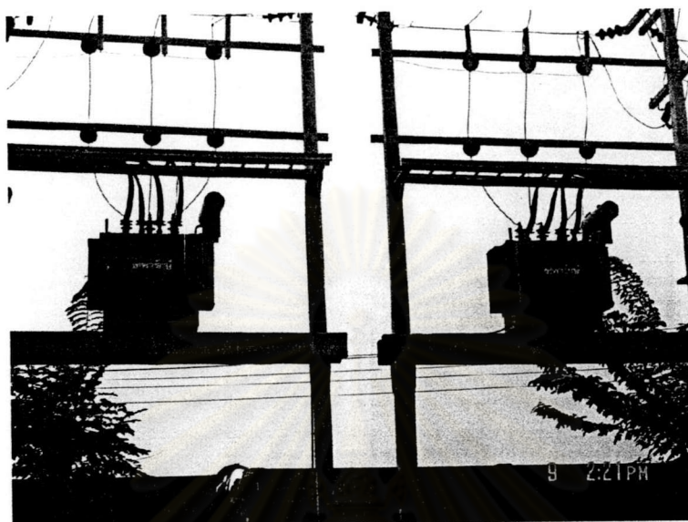
ภาพที่ 4-9 หม้อแปลงไฟฟ้า
