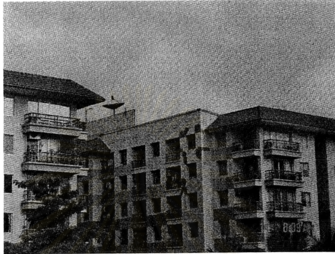
ภาพที่ 4-15 ถังน้ำดาดฟ้าอาคาร
