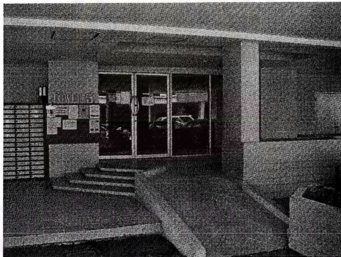
ภาพที่ 4-28 ทางลาดเข้าอาคาร
