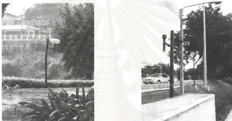
ภาพที่ 6.2.4-1 และ 6.2.4-2 แสดงลักษณะของเสาไฟที่ถูกทำลาย
