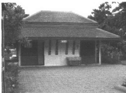
ภาพที่ 4.8-3 แสดงลักษณะของห้องน้ำสาธารณะภายในโครงการ บริเวณลานอเนกประสงค์กลางแจ้ง
