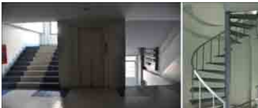
รูปที่ 4.34 แสดงบันไดและโถงลิฟต์ในอาคาร River Court
