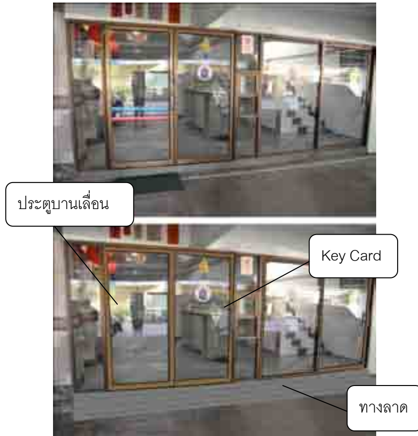
รูปที่ 6.2 แสดงการปรับปรุงทางเข้าออกอาคาร
