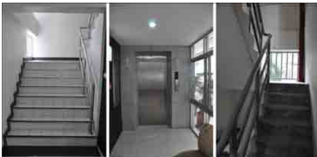
รูปที่ 4.49 แสดงบันไดและโถงลิฟต์ในโครงการ J-Visut Place
