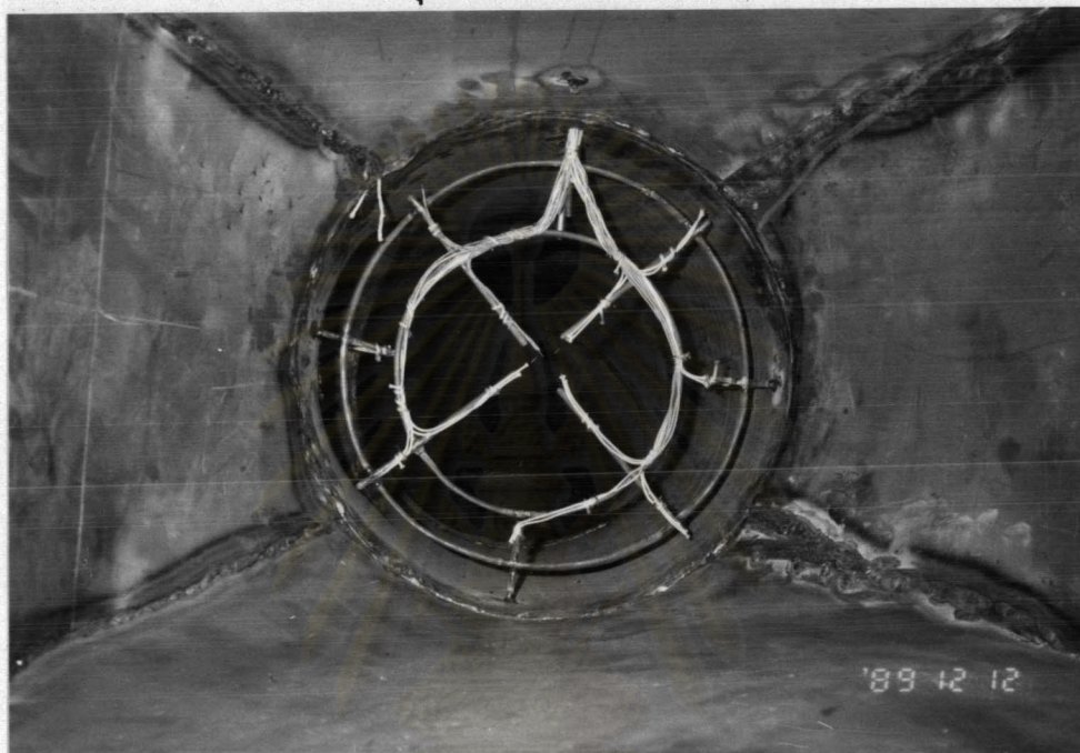
รูปที่ 3.22 ภาพแสดงชุดการติดตั้งชุดเทอร์โมไฟล์ภายในท่อ
