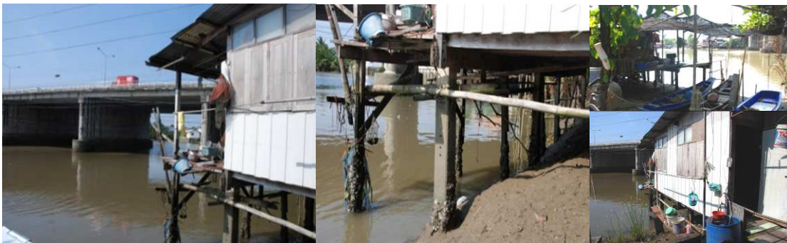
ภาพที่ 4.13 แสดงรูปลักษณะที่อยู่อาศัยของนายสุชาติ จิวประสาน ที่ถูกน้ำกัดเซาะ
