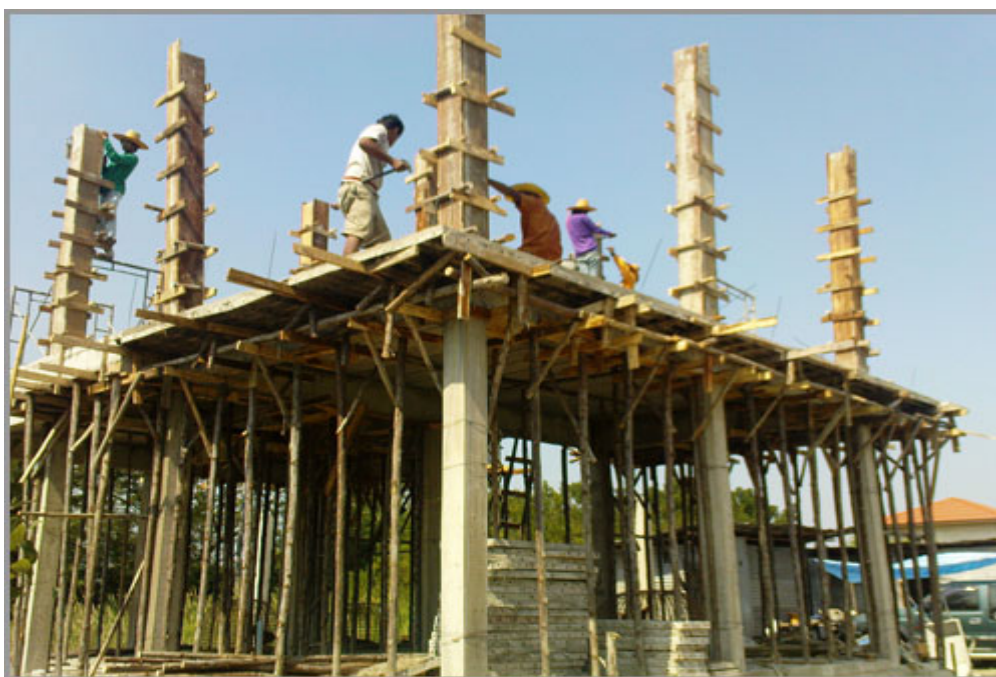
ภาพที่ 5.1 แสดงรูปแบบการก่อสร้างด้วยระบบหล่อในที่
