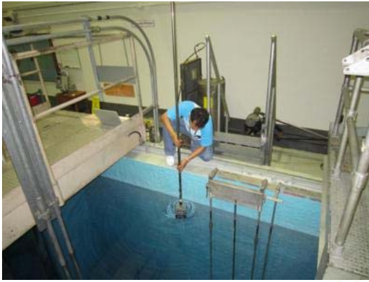
(ก) ติดตั้งระบบ
