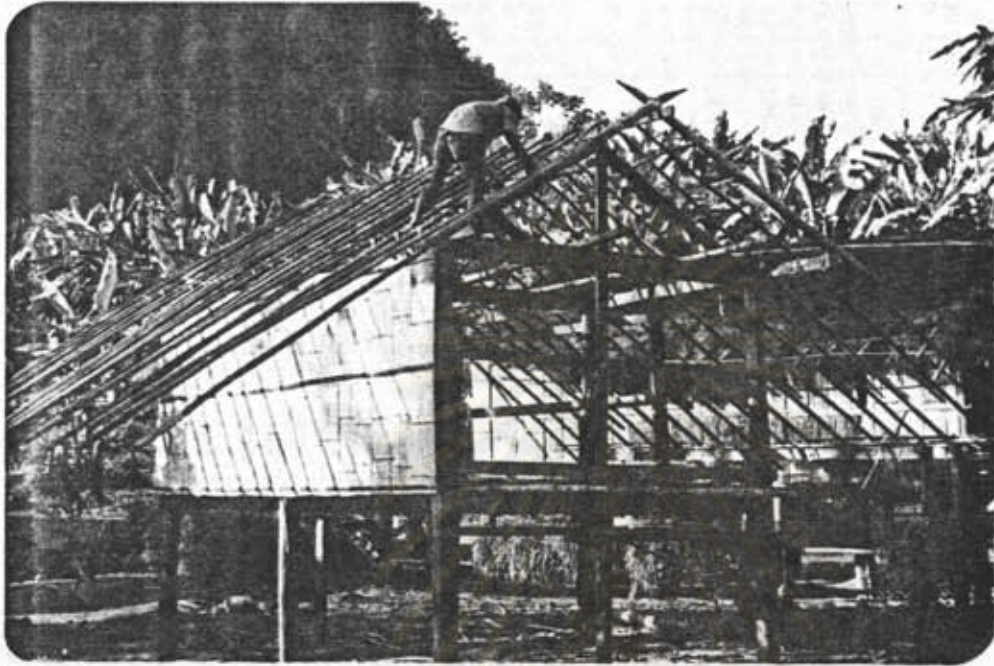
การปลูกเรือน เสาและโครงสร้างไม้จริง ฝาฟากสับ
