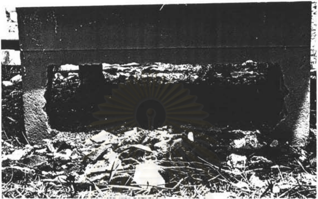
รูปที่ 4.14 แสดงการเปิดช่องให้ลมเข้าด้านล่างของปล่องมวลมาก
