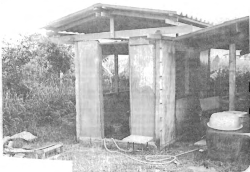
รูปที่ ๘๗ ข อาคารคอนกรีตเสริมไม้ไผ่
