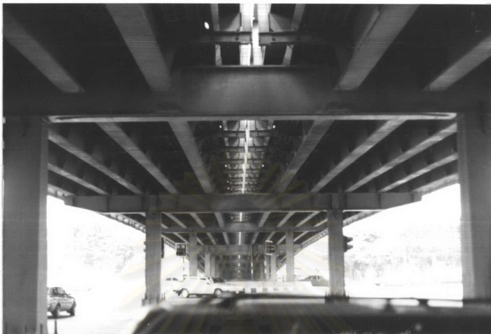
รูป 2.7 รูปถ่ายแสดงระบบคานของสะพานลอยไทย-เบลเยียม
