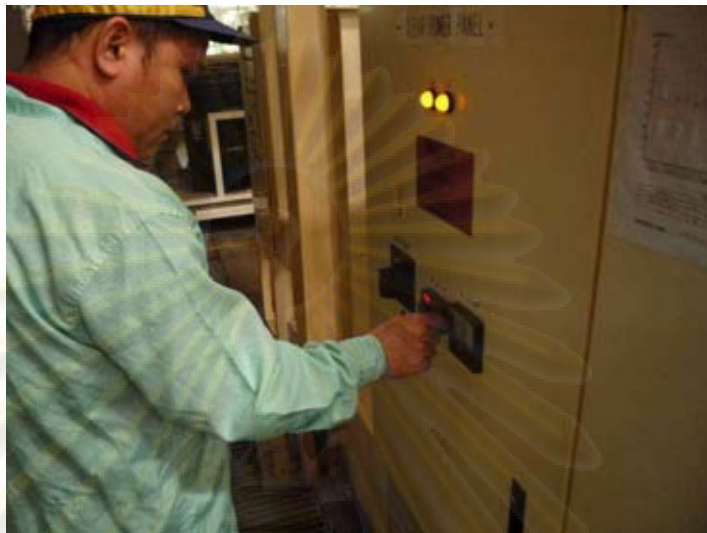
รูปที่ 5.1 ภาพการปรับตั้งความถี่ของมอเตอร์ระบบจ่ายอากาศ
