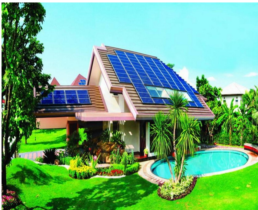
ภาพที่ 2.16 ตัวอย่างอาคารบ้านพักอาศัยที่ติดตั้ง Solar roof ขนาด 7kW
