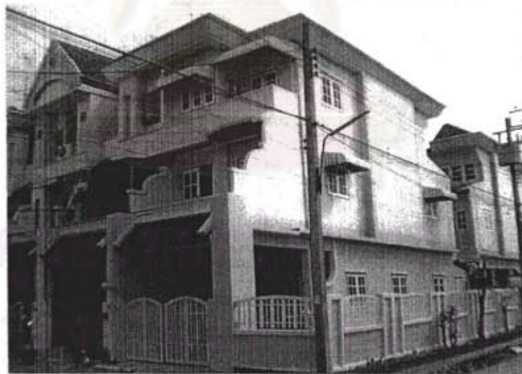
ภาพที่ 5.18 ตัวอย่าง ทาวน์เฮ้าส์หลังริมที่ตรวจสอบภาพได้ทั้งด้านหน้าและด้านข้าง
