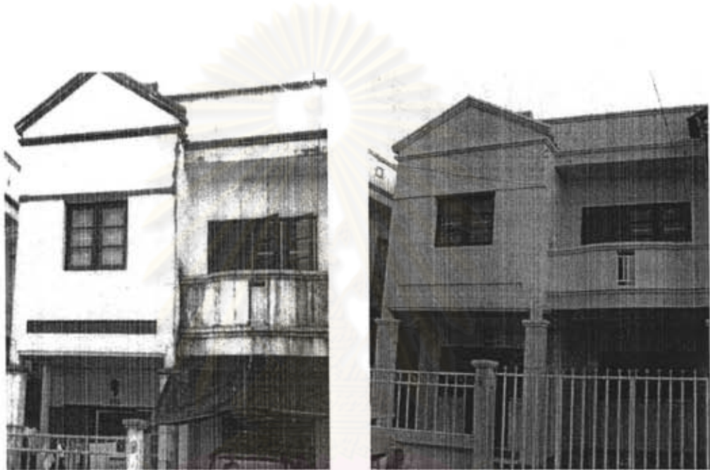
ภาพที่ 5.49 ตัวอย่างทาวน์เฮ้าส์ที่ซื้อจากการประมูล ก่อนและหลังจากปรับปรุงซ่อมแซม
