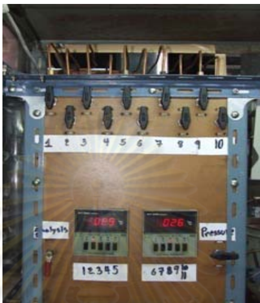
รูปที่ 3.19 หน้าจอแสดงอุณหภูมิและวาล์วสำหรับดึงแก๊สออกจากระบบ
