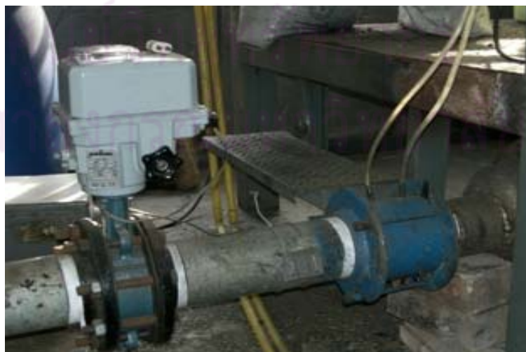
รูปที่ 3.9 วาล์วไฟฟ้ารูปผีเสื้อและ Orifice
