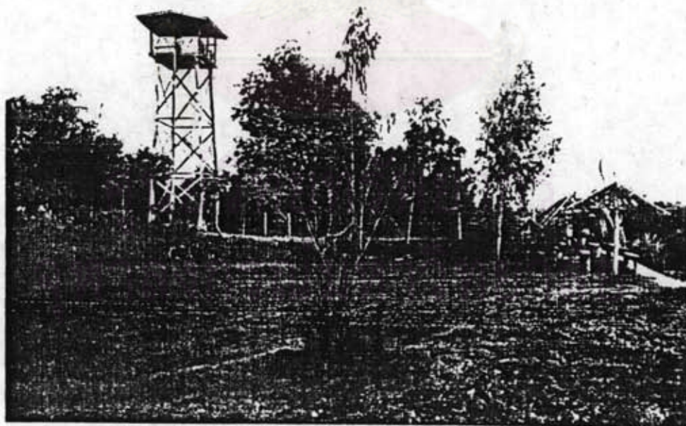
๔. โครงการประปาหมู่บ้าน สร้างจากเงิน กสช. พ.ศ. 2526 สูบน้ำจากฝ่ายน้ำล้นห้วยทับไต้ ส่งไปตามหมู่บ้าน
