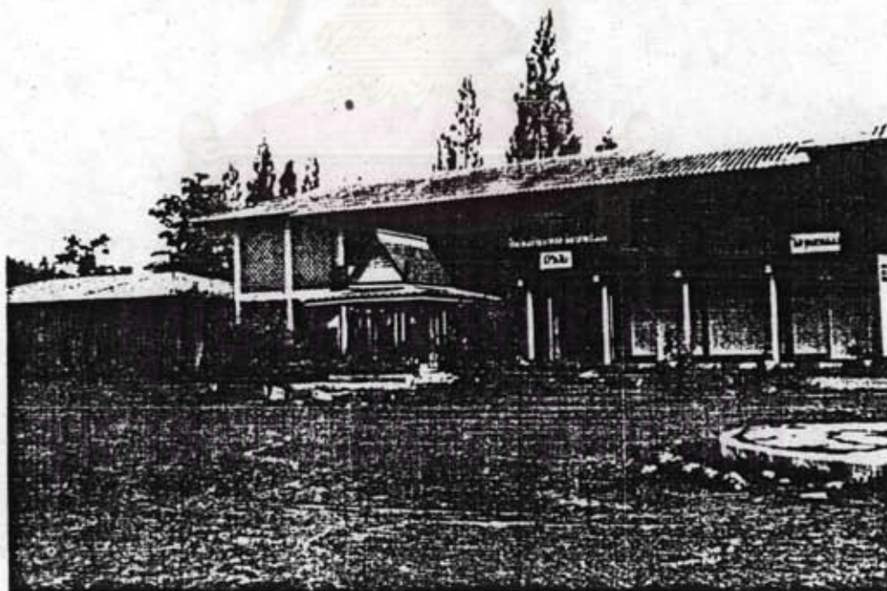
6. สภาอาคารเรียน ชำยมือ เป็นอาคารเรียนหลังเก่าที่ราษฎรก่อสร้างกันเอง ชาวบ้านเป็นอาคารเรียนที่ทางราชการก่อสร้าง
