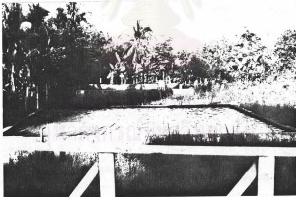
ภาพที่ 5.37 สภาพของถังทรายกรองช้าทั้ง 2 ใบ ในภาพด้านนอกเป็นถังกรองใหม่ และด้านในเป็นถังกรองเก่า
