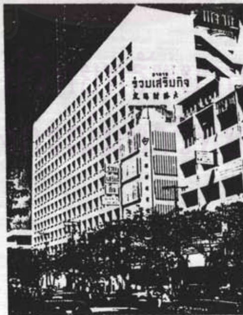
ภาพที่ 3.1 อาคารสำนักงาน
