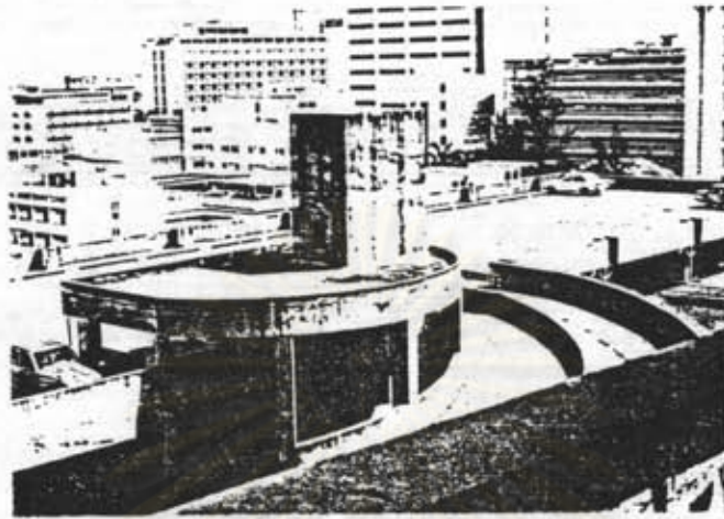
ภาพที่ 3.2 อาคารจอดรถ
