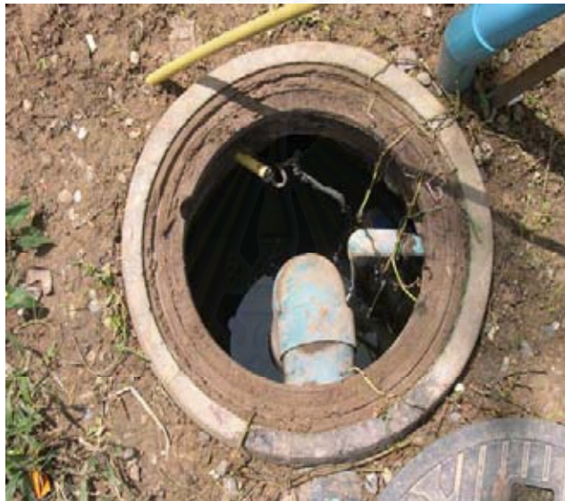
รูปที่ 3.3 น้ำทิ้งจากระบบบำบัดน้ำเสียสำหรับที่พักอาศัย
