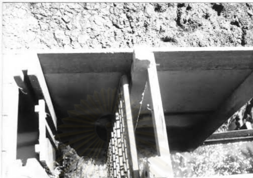
ภาพ 3.6 ประตูน้ำแบบใช้เสาแม่ประตูเขาระ่อง ใช้แผ่นกระดานซักเข้าออก
