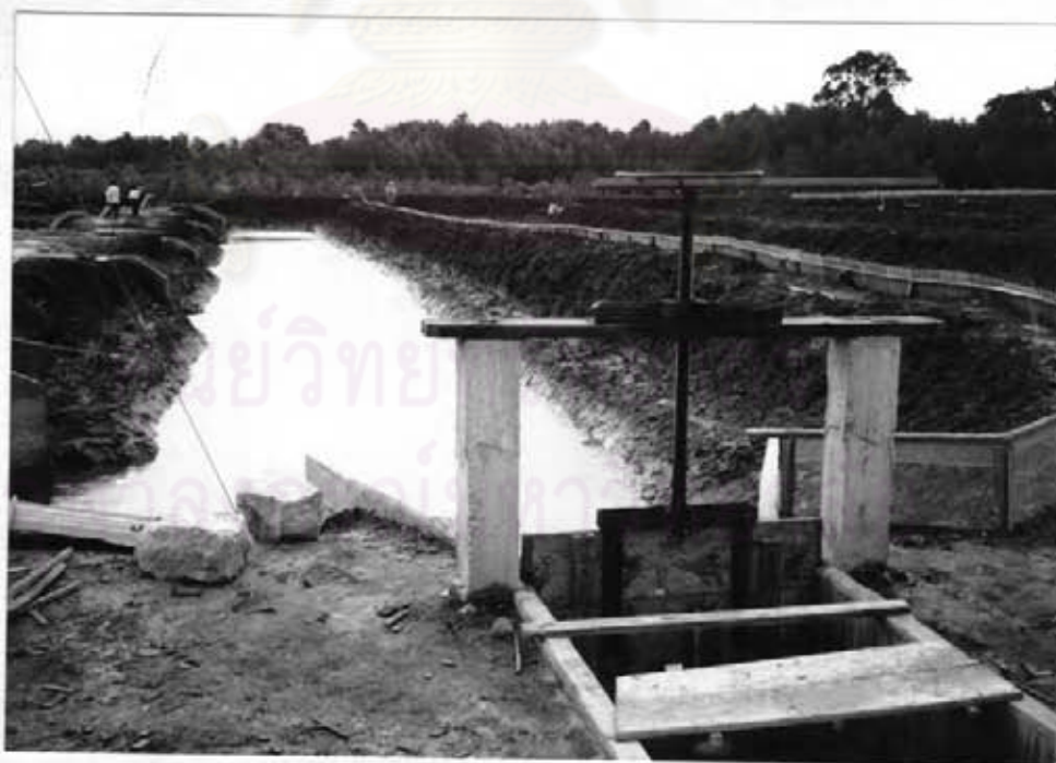
ภาพ 3.9 คลองส่งน้ำและประตูน้ำย่อยตลอดแนวคลอง
