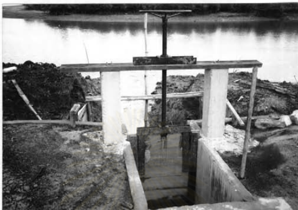
ภาพ 3.8 ประตูน้ำคอนกรีตสำหรับฟาร์มขนาดใหญ่
