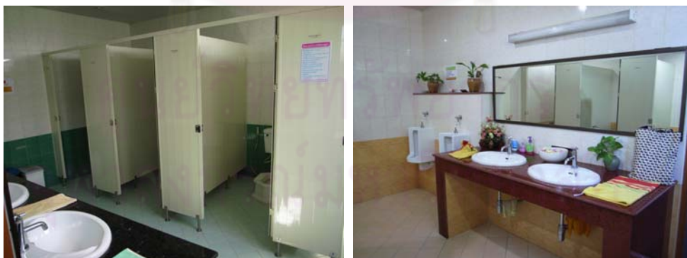
ภาพที่ 4.27 แสดงห้องน้ำภายในอาคารพระสถธรรมชั้น 1
