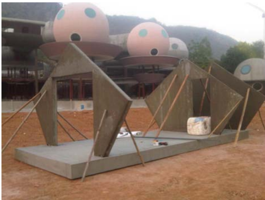
ภาพที่ 4-47 แสดงขั้นตอนการติดตั้งผนัง 5 เหลี่ยมด้านหน้า และด้านหลัง ขอบยึดติดด้วย base coat ทำค้ำยัน ใช้เวลา 2 วันเพื่อให้แห้งสนิทเพิ่มความแข็งแรง
