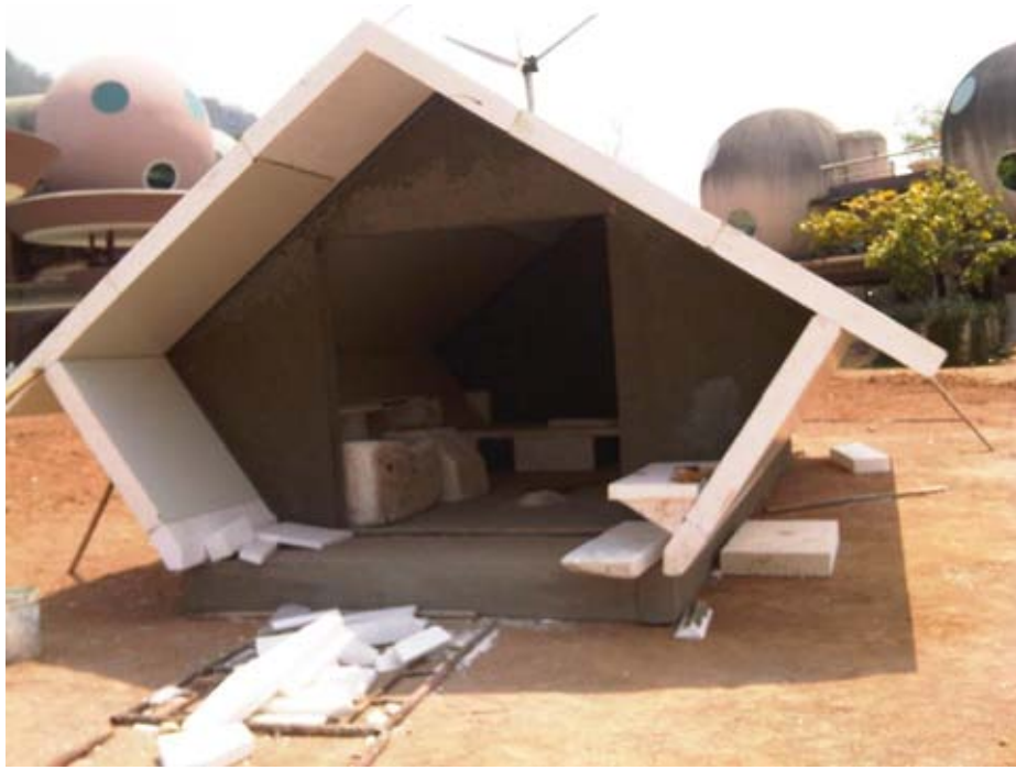
ภาพที่ 4-52 แสดงขั้นตอนการแสดงก่อสร้างจริงขณะติดตั้งผนังและหลังคา
