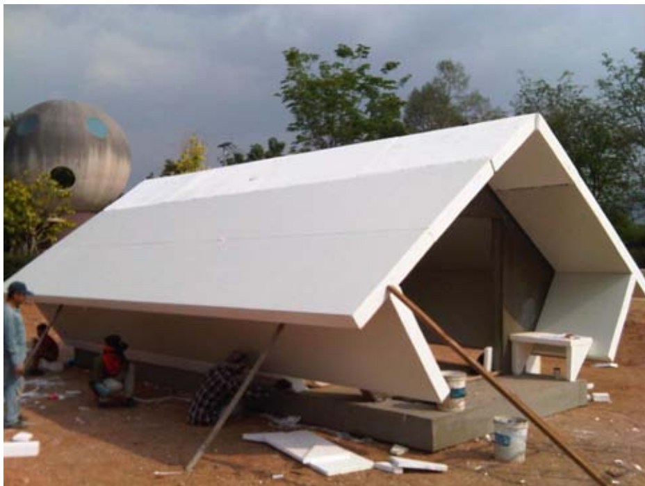
ภาพที่ 4-51 แสดงขั้นตอนการติดตั้งก่อนสร้างจริง ขณะติดตั้งผนังและหลังคา
