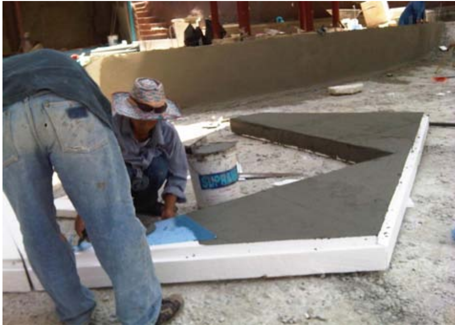
ภาพที่ 4-44 แสดงขั้นตอนการแสดงการติดตะแกรงไฟเบอร์กลาส เพื่อฉาบผิว
