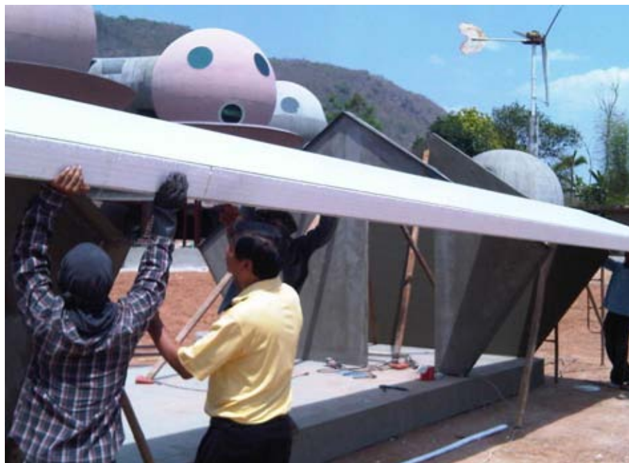
ภาพที่ 4-49 แสดงขั้นตอนการติดตั้งชิ้นส่วนผนัง โฟม panel ส่วนหลังคา
