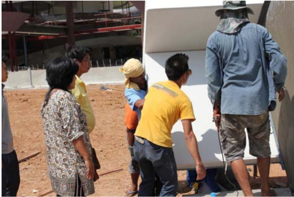
ภาพที่ 4-50 แสดงขั้นตอนการติดตั้งชิ้นส่วนผนัง โฟม panel ด้านข้างทั้ง 2 ด้าน และส่วนหลังคา
