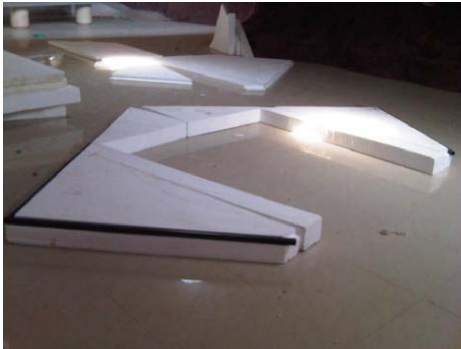
ภาพที่ 4-43 แสดงขั้นตอนการเตรียมโฟม EPS ชนิดกันไฟลามสำหรับผนังด้านสกัด
