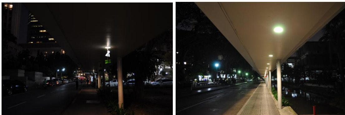
รูปที่ 5-7 ซ้ายสถานีที่ 10 ขวาแนวทางเสนอนแนะนำการปรับปรุงแสงสว่างสถานีที่ 9
