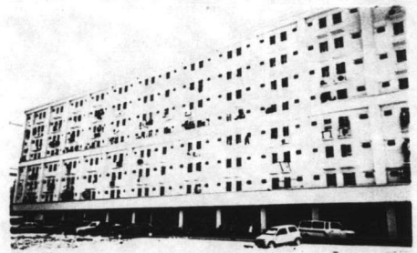
รูปที่ 4-80 เจริญชัย คอนโด 476 หน่วย หลังโรงงานสีเทา
