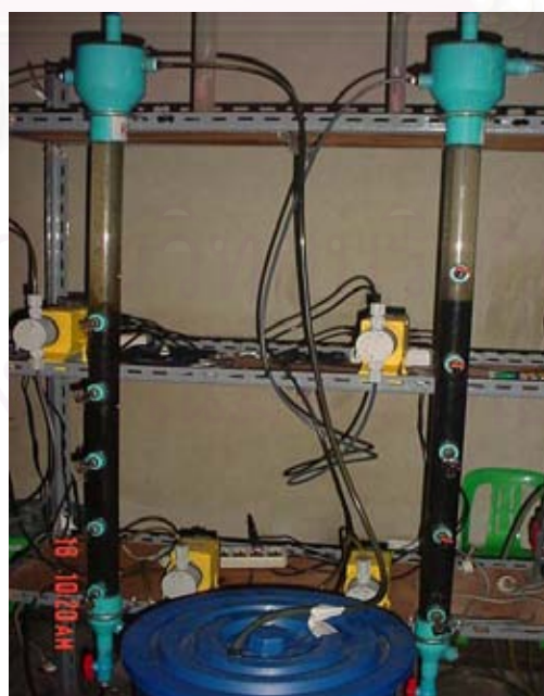
รูปที่ 3.3 การติดตั้งระบบอีจีเอสบี
