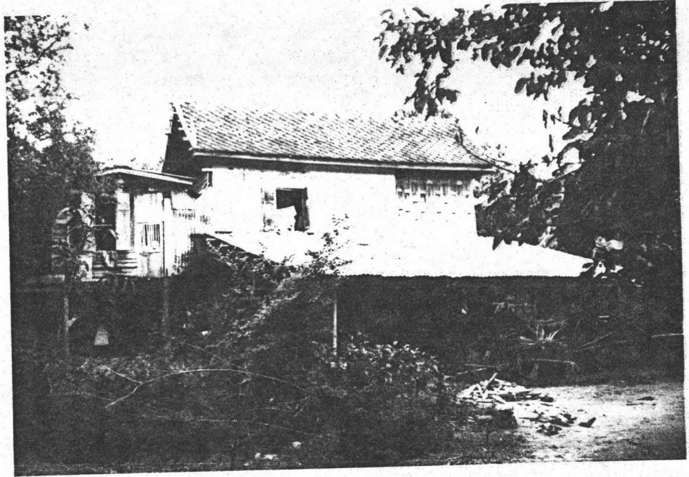
สภานบ้านพักอาศัยของ เกษตรกร แขวง โคนแฝด
