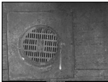
(ก) ฝาแมนโฮลบนถนนคอนกรีต
